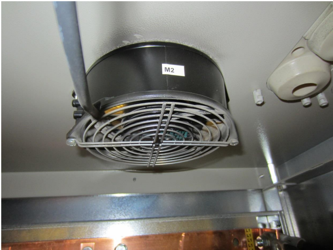
Kuva 10. Nokian Capacitors Ziehl W2S130 -tuuletin.
