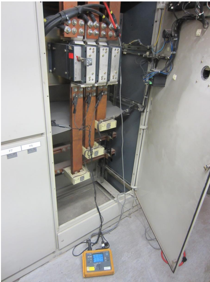
Kuva 11. Analysaattorin asennuksessa tulee olla erittäin varovainen, koska usein mittapäätt joudutaan asentamaan paljaisiin jännitteisiin osiin.
