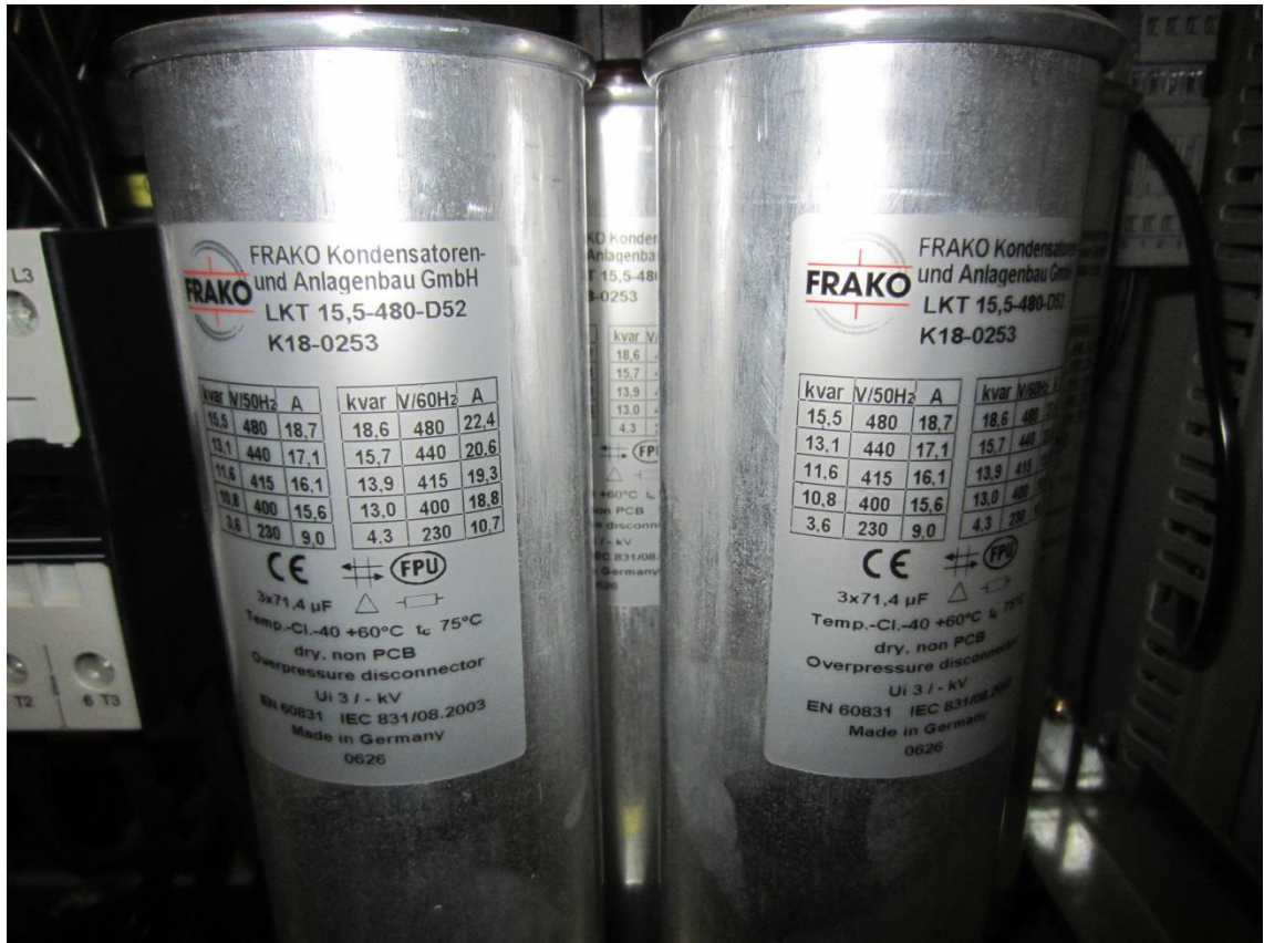
Kuva 16. Frakon kondensaattori, jonka arvoista näkee hyvin, miten jännite vaikuttaa virtaan ja loistehoon.
