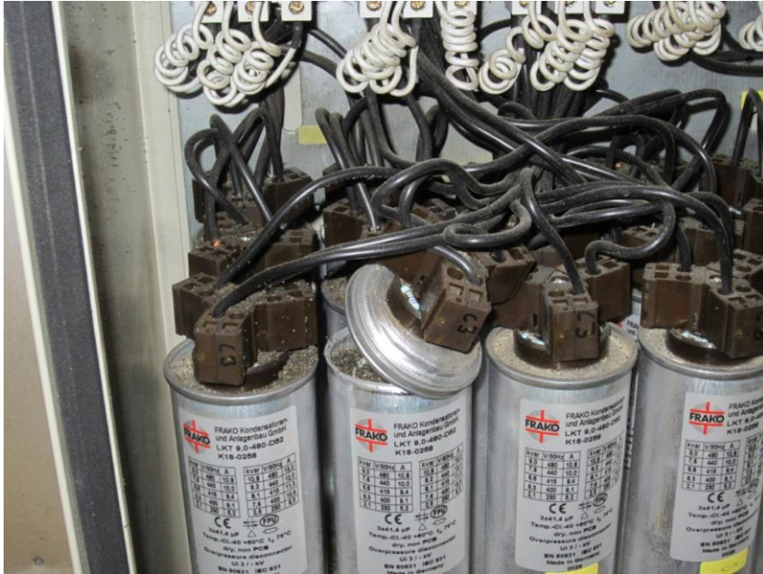
Kuva 13. Aistinvaraisessa tarkistuksessa tulee kiinnittää huomiota komponenttien kuntoon.
