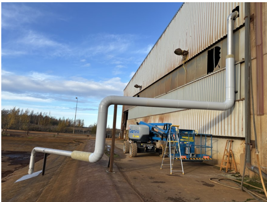
Kuva 8. Selkeyttimestä (P22.01) maa-aitaille johtavan uuden putken loppuosa.
