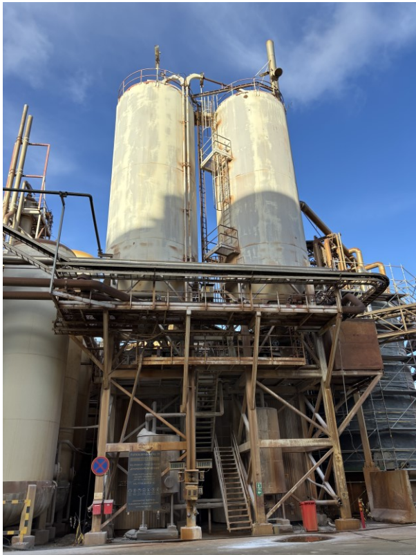
Kuva 5. Kalkkisiilot ja niiden alapuolella liettosäiliöt.
