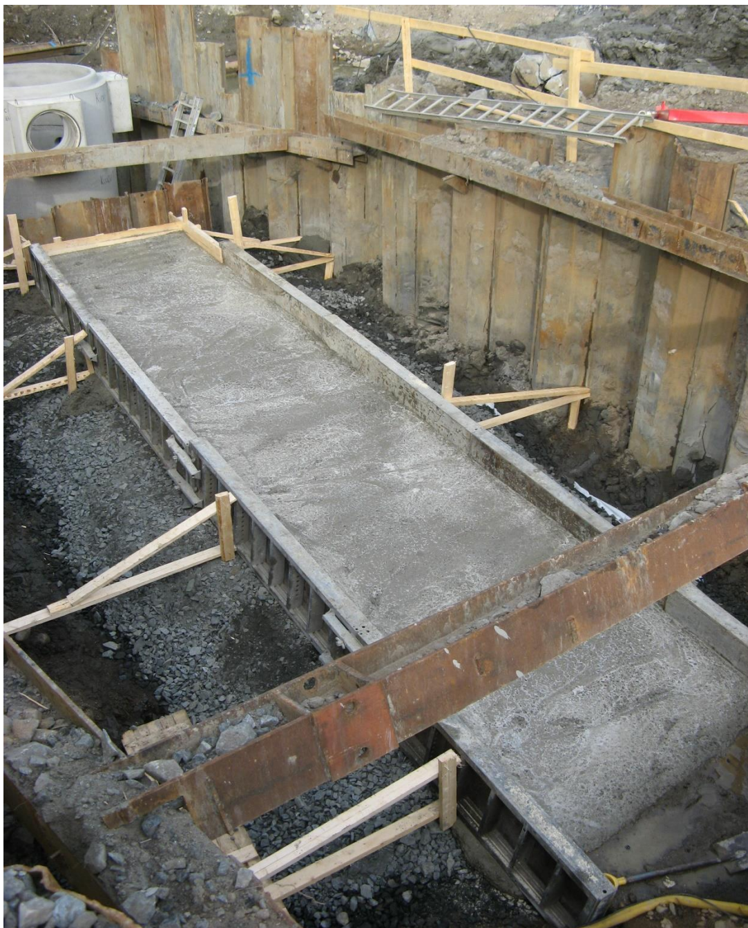
Kuva 3. Juuri valettua paalulaattaa Puijonkadun risteyksessä (Partanen 2014-6-20.)
