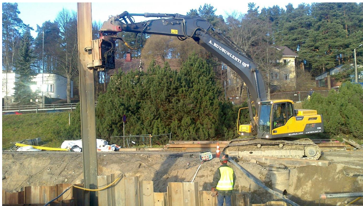
Kuva 1. Ponttuitustyötä Puutarhakadulla (Partanen 2013-8-31.)
