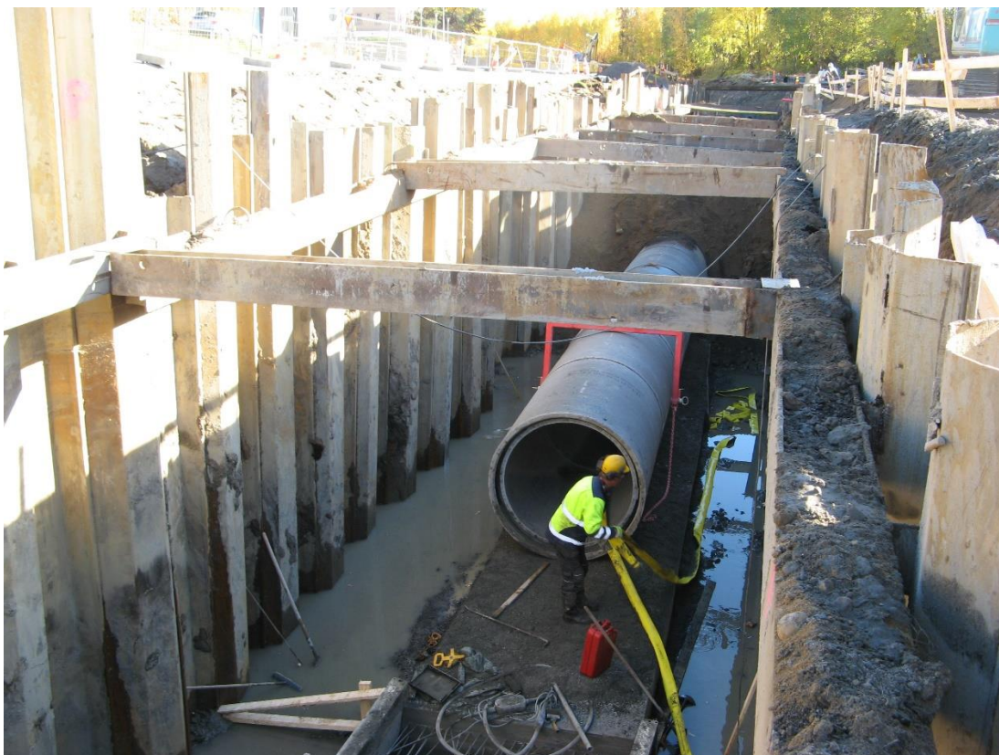
Kuva 2. HEB-palkein tuettu ponttikaivanto Puutarhakadulla (Partanen 2013-8-8)
