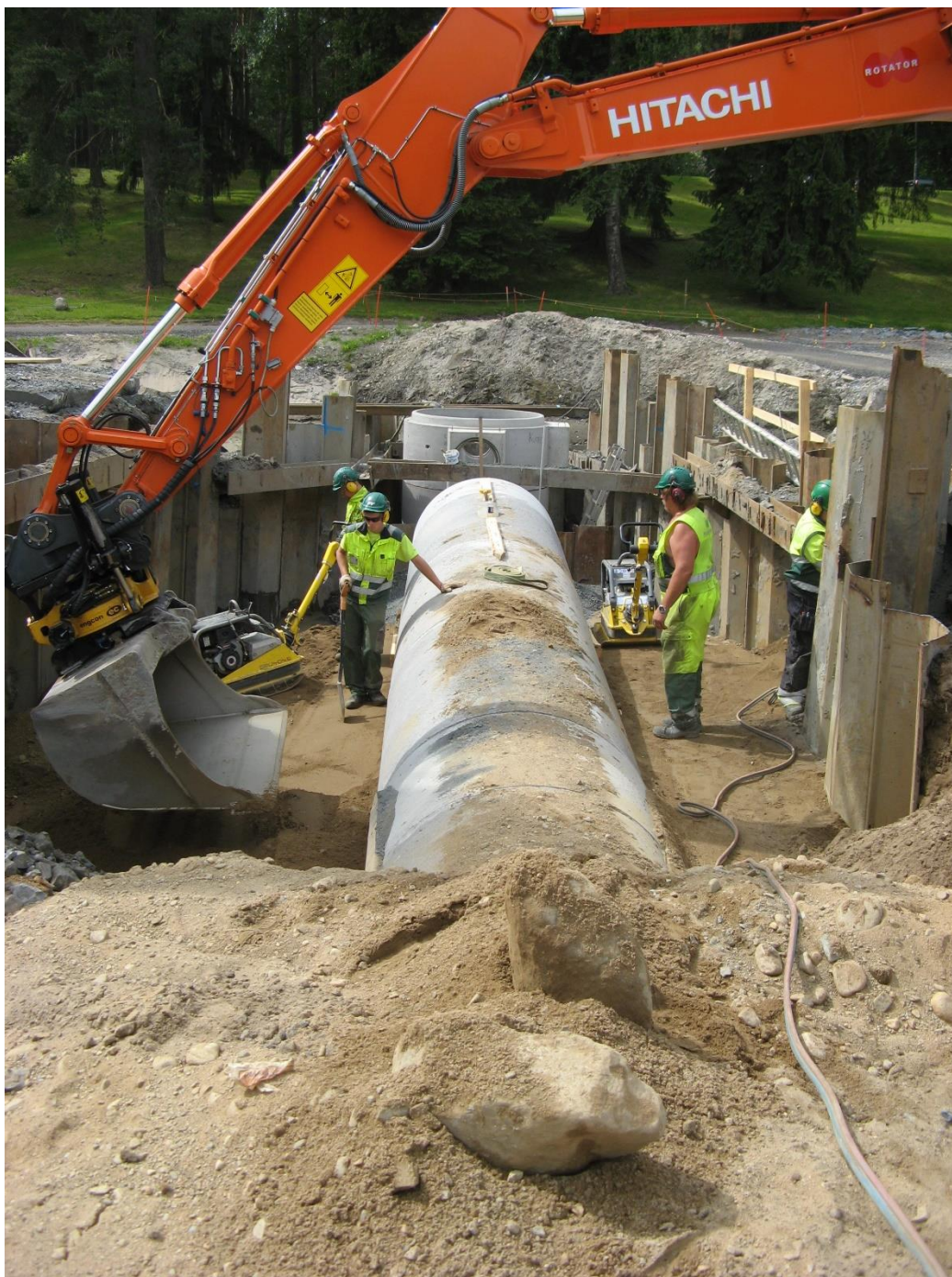
Kuva 5. Hulevesilinjan alkutäyttöä Puijonkadun risteuksen tuntumassa (Partanen 6-25-2014.)
