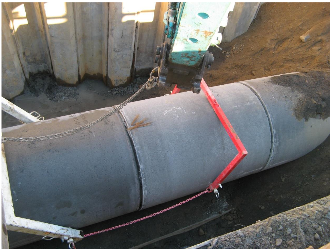
Kuva 4. Putkien asentamista Kona-asennuslaitteella (Partanen 2013-08-08).
