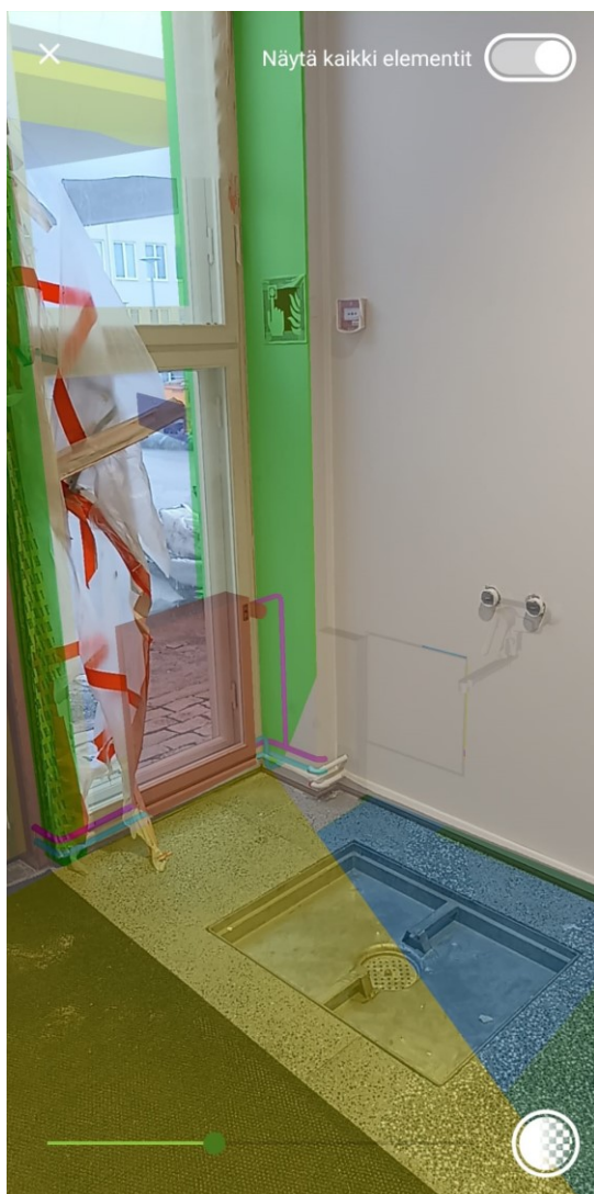
Kuva 9. Mobiililaitteen näkymä TwinBIM-työkalun ollessa päällä paikasta, jossa asennukset ovat kesken.
