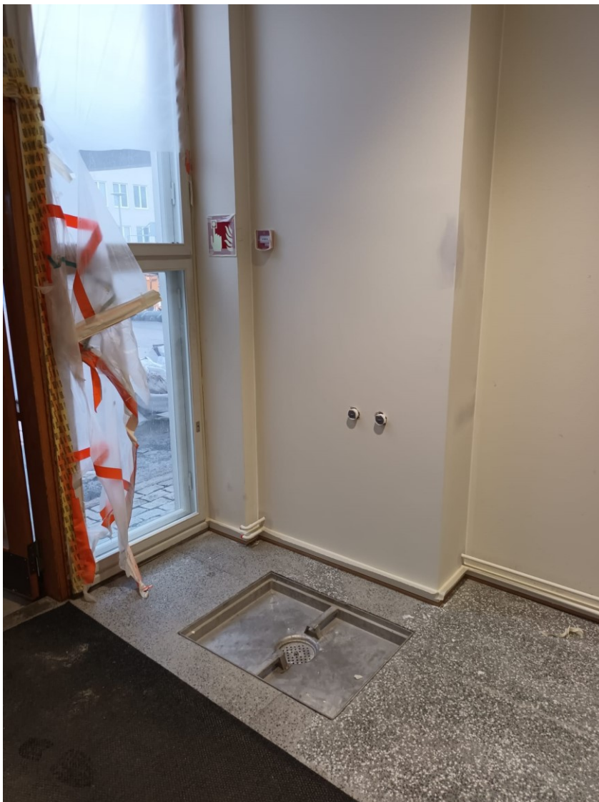
Kuva 8. Kuva rakennuksen aulasta, jossa patteri ja sen kytkennät ovat kesken.
