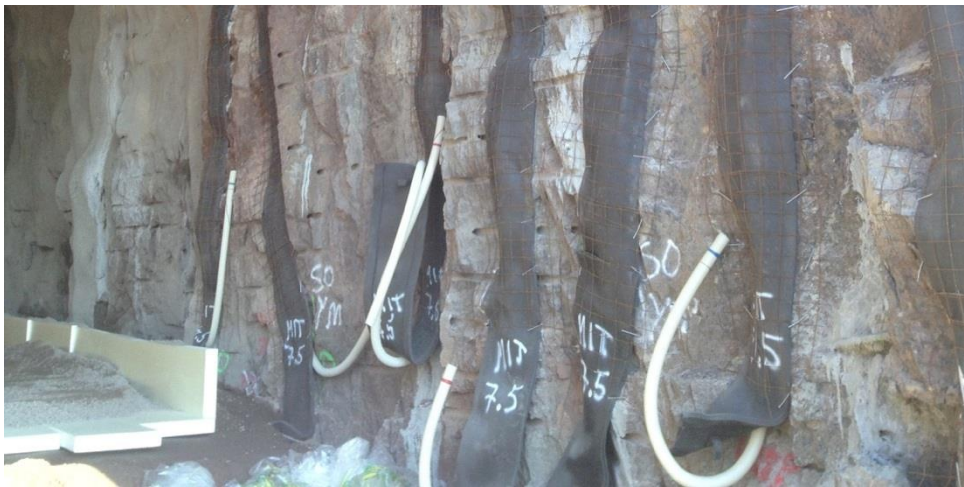
Kuva 4. Asennetut salaojat [Kuva: Pihlström 2013]
