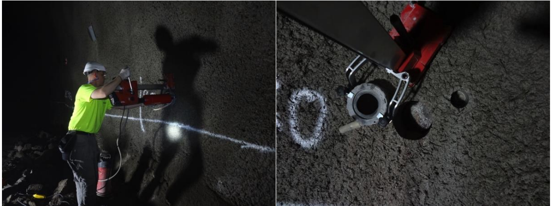
Kuva 18. Valmiin ruiskubetonirakenteen rakennekoekappaleiden irrotus [Kuva: Saanio & Riekkola Oy]
