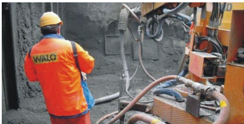
Kuva 11. Ruiskubetonikoelaatan valmistus [Guirguis 2013]
