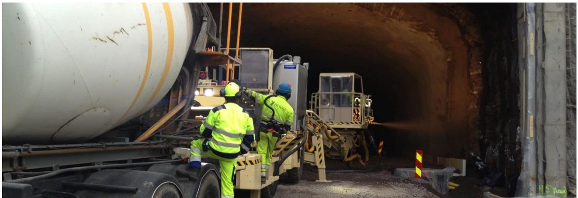
Kuva 3. Ruiskubetonointi märkäseosmenetelmää käyttäen [Kuva: Pihlström 2013]
