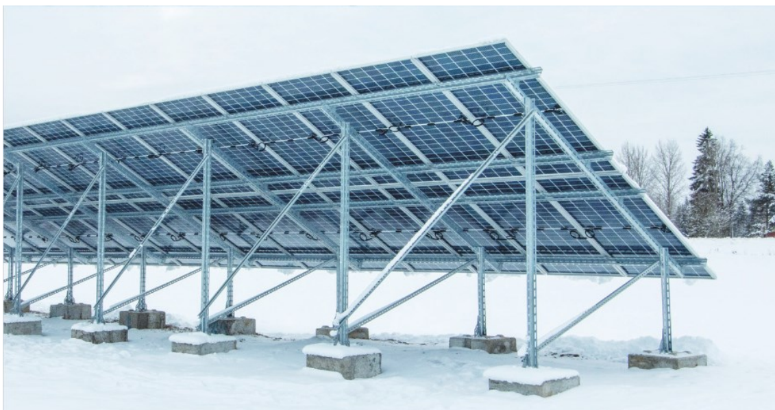
KUVA 3. Aurinkopaneelijärjestelmän teräsrakenteet betoniperustuksiin ankkuroituina (MEKA Nordic PV System 2024).
