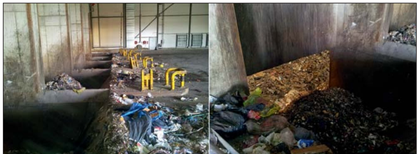
KUVA 3. Jätteiden vastaanottoalue (kuva Panu Jouhkimo)
