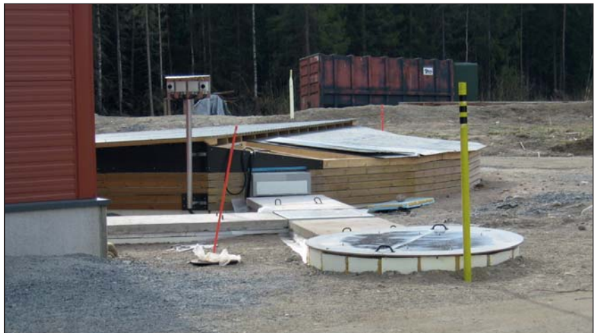
KUVA 2. Matalan kiintoainepitoisuuden omaavat jakeet, kuten lietteet, kipataan suoraan katettuun syöttösäiliöön (kuva Hanne Soininen)
