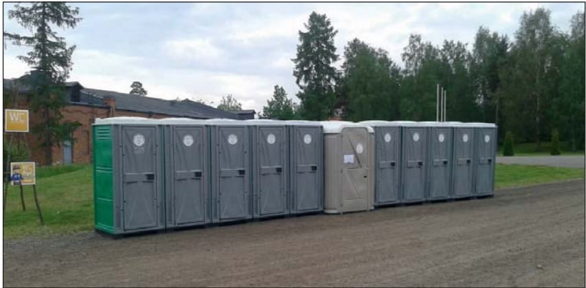
KUVA 1. Käymälät lauantaipuhtausalueella. Pisuaarit on sijoitettu näkösuojan koppivessojen taakse. (kuva Toni Sakki)
