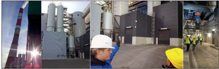
KUVA 6. Vasemmalta oikealle Irun jätevoimalaitoksen 202,4 metriä korkea piippu, savukaasujen puhdistusyksikkö sekä purkujärjestelmä kaasunpuhdistusjätteille sekä lento- ja pohjatuhkille (kuvat Panu Jouhkimo)
