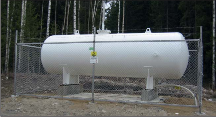
KUVA 4. Biometaanin välivarastointisäiliö (kuva Hanne Soininen)
