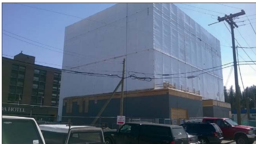
KUVA 3. Puukerrostalon rakennusaikainen suojaus sateelta (kuva Jussi Levonen)
