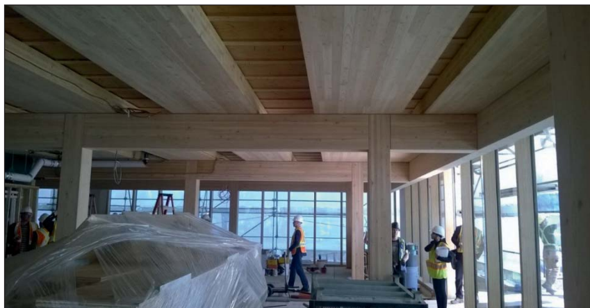
KUVA 5. Puukerrostalorakennustyömaa. Prince George, Kanada (kuva Jussi Levonen)
