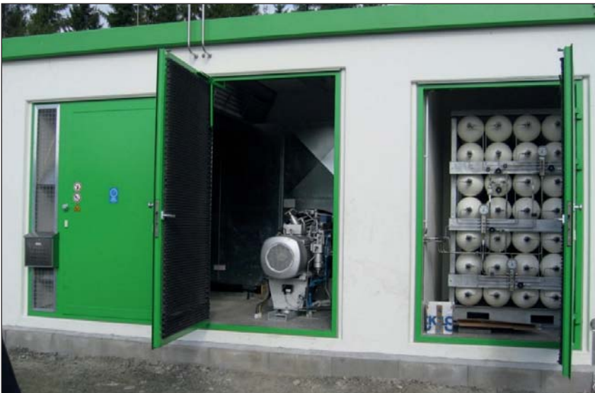
KUVA 5. Tankkausaseman yhteydessä oleva kaasun paineistamo, kuivausyksikkö ja korkeapainepullovarasto (kuva Hanne Soininen)
