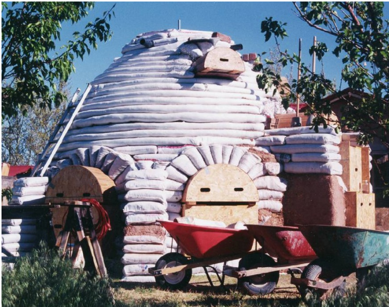
KUVA 7. Kupolikattoinen, osin maan alle haudattu, maasäkkitalo rakennusvaiheessa (Hunter – Kiffmeyer 2004, 131)
