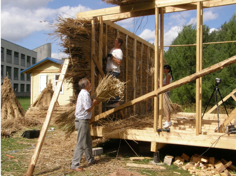
KUVA 4. Viron ammattikorkeakoulun opiskelijat asentamassa vaakasuoraa ruokoeristettä (Karja – Miljan – Miljan – Akermann 2010)
