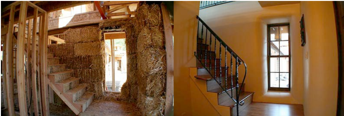
KUVA 5. Kuva olkipaalirakenteisesta talosta rakennusvaiheessa ja sen jälkeen (Edmonds)
