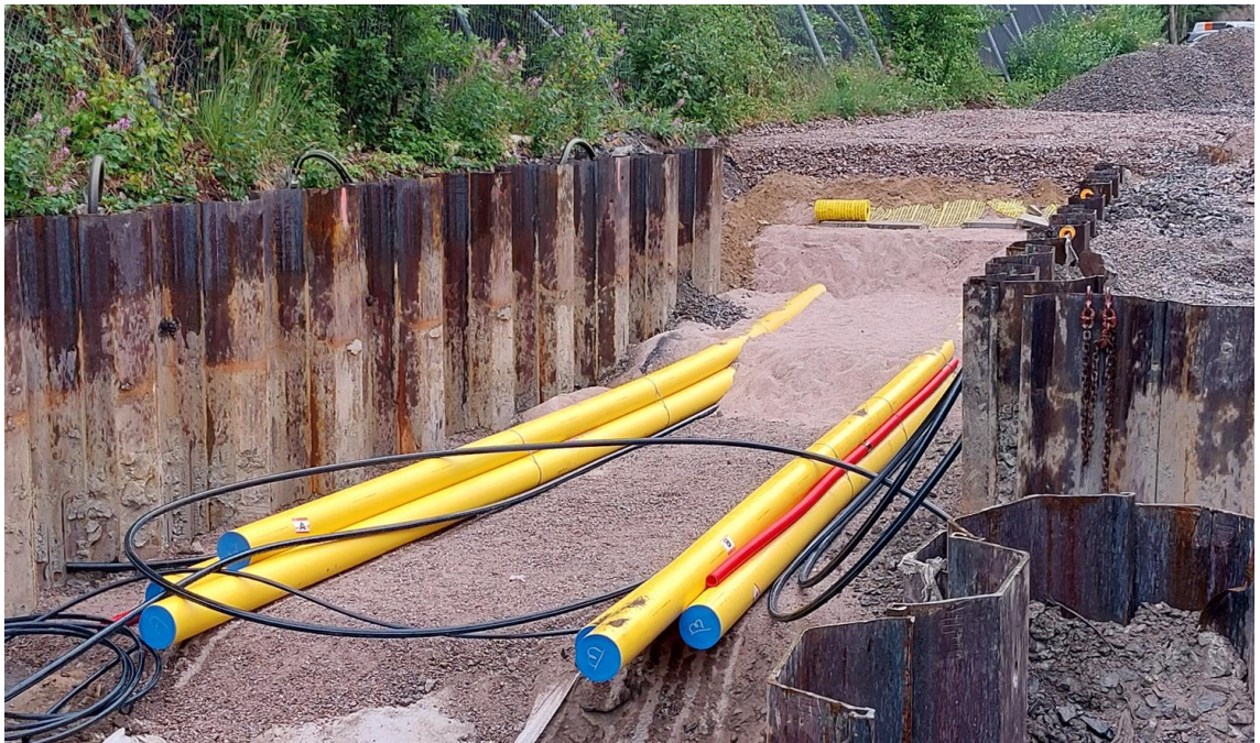
KUVA 8. Kaapeliputkituksia asennettu tuettuun kaivantoon. Putket ovat asennettu suojahiekkaan sekä suojattu betonilaatoin ja betonilaattojen yläpuolelle asennetaan varoitusverkko. (Ville Mäkinen 2024.)
