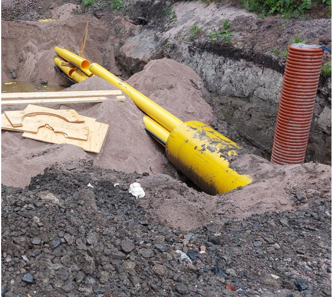
KUVA 11. Putkitukset alitusporauksessa. (Ville Mäkinen 2024.)
