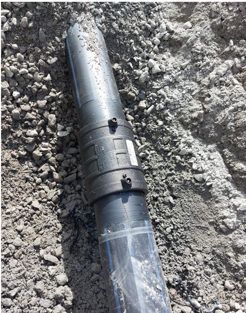
KUVA 13. Sähköhitsausmuhvi 110 PE putkessa. (Ville Mäkinen 2024.)
