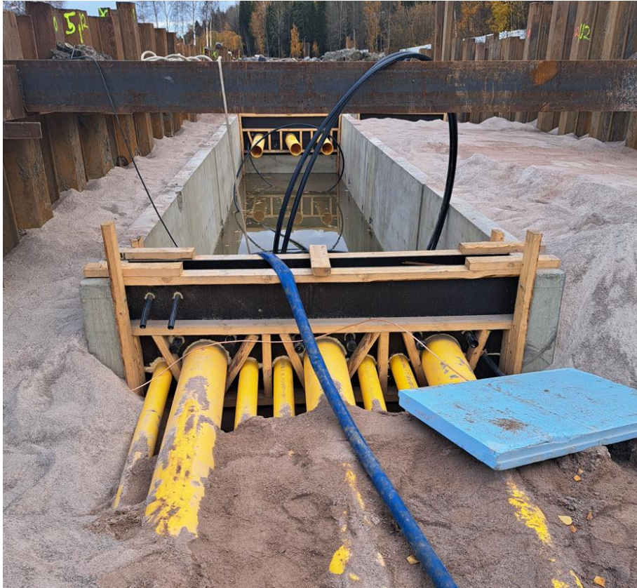
KUVA 18. Jatkostila asennettuna tuettuun kaivantoon. (Ville Mäkinen 2024.)
