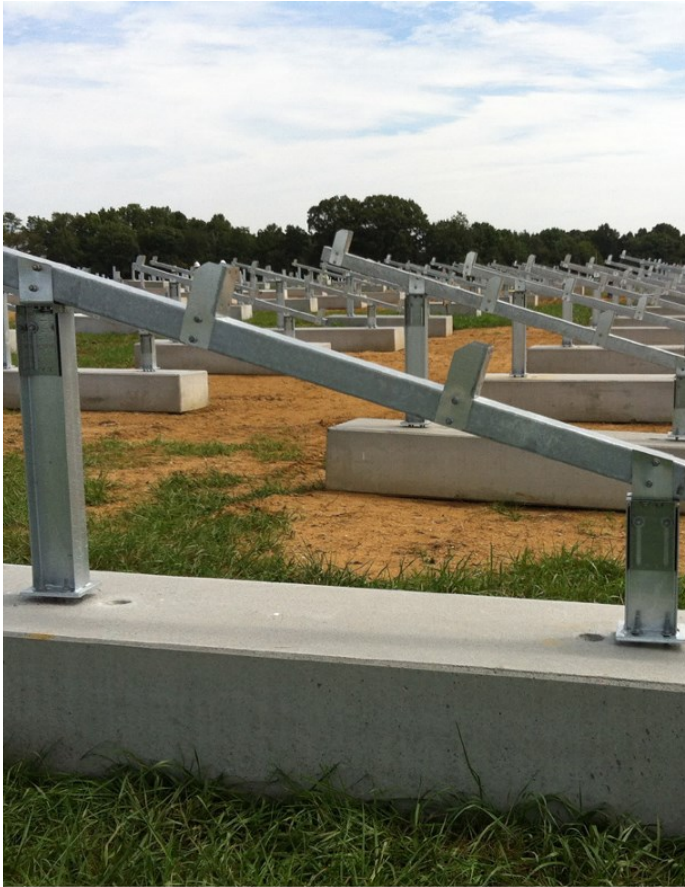
Kuva 6. Kuva betonipainoperustuksesta (Terrasmart, n.d.).
