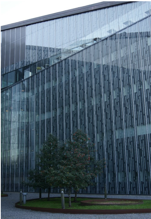
KUVA 6. Kuvassa on nähtävillä Tampereen Tipotien sosiaali- ja terveysaseman lasijulkisivussa käytettyä pystysuuntaista viivoitusta
