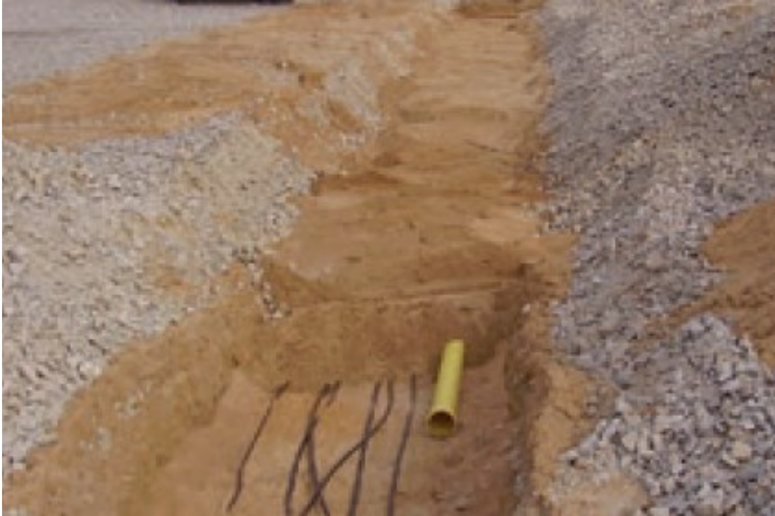
KUVA 7. Ohjeiden mukaan toteutettu maakaapelointi ja 110 mm varaputki. Varoituss nauha on vielä asentamatta (29, s. 68).
