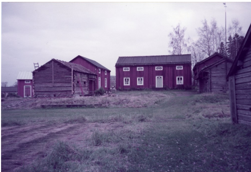
Kuva 3. Stundarsin maalaistalon pihapiiri vuonna 1984. Tuolloin leipomon päätyyn rakennettiin talli (kuvassa vasemmalla), joka siirrettiin Mustasaaren Koivulahdesta. (Nieminen 1984).
