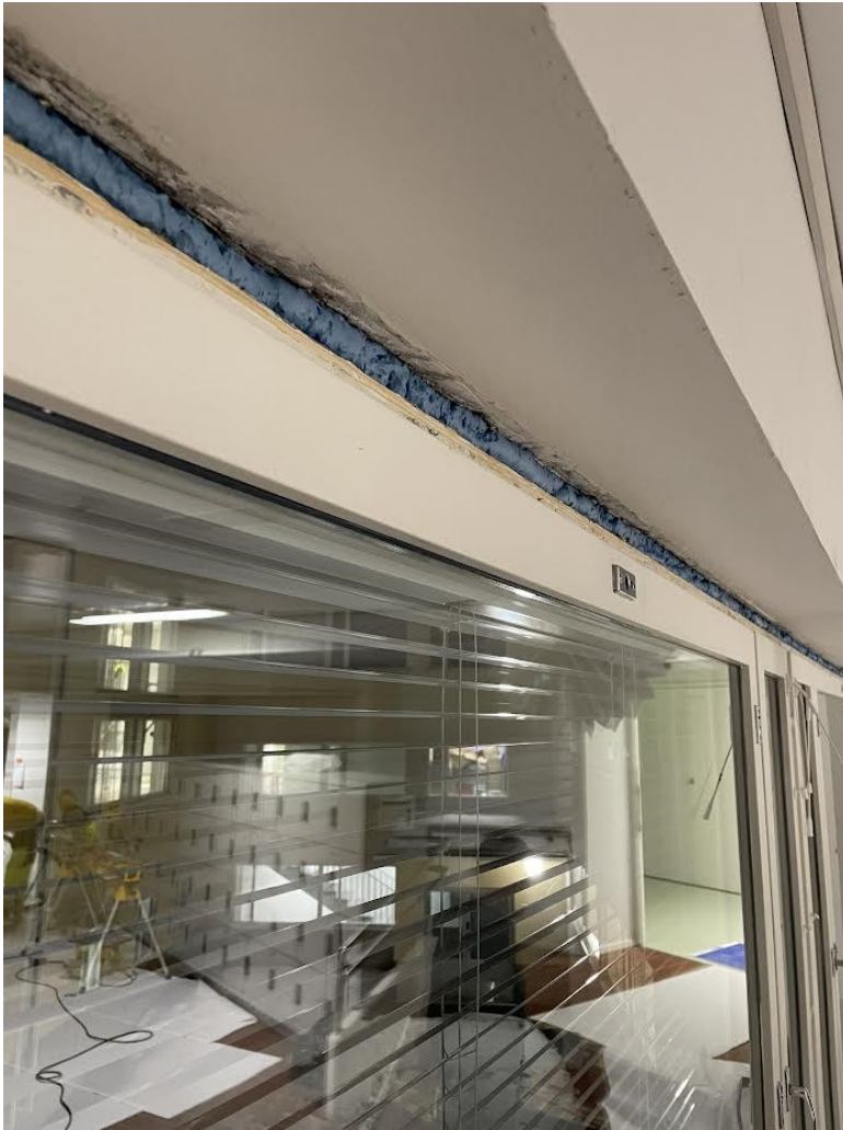
Kuva 2. Ikkuna-seinäliittymä ennen tiivistystä.
