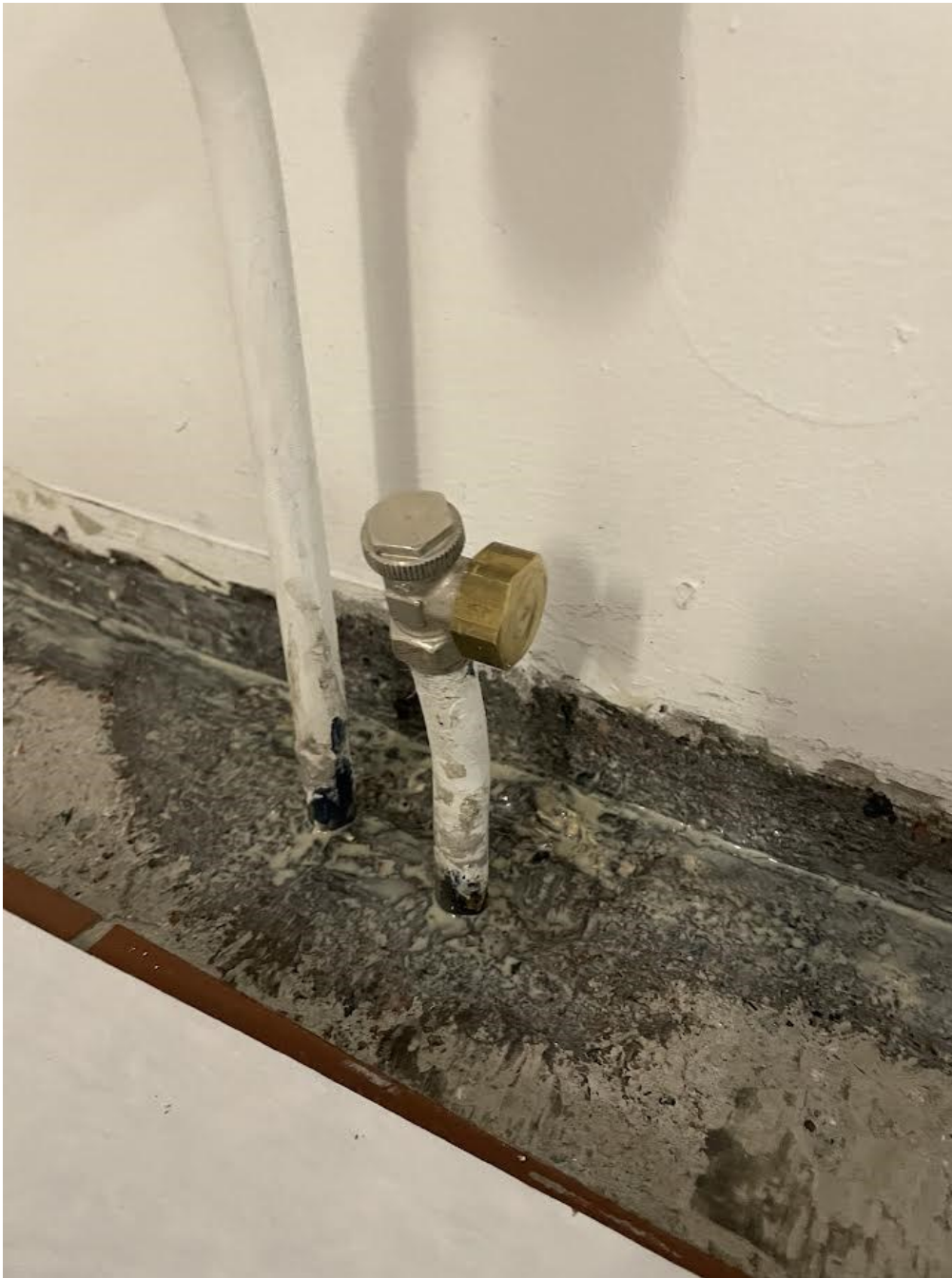
Kuva 3. Alapohjasta tulevien patteriputkien läpivientien tiivistys aloitettu.
