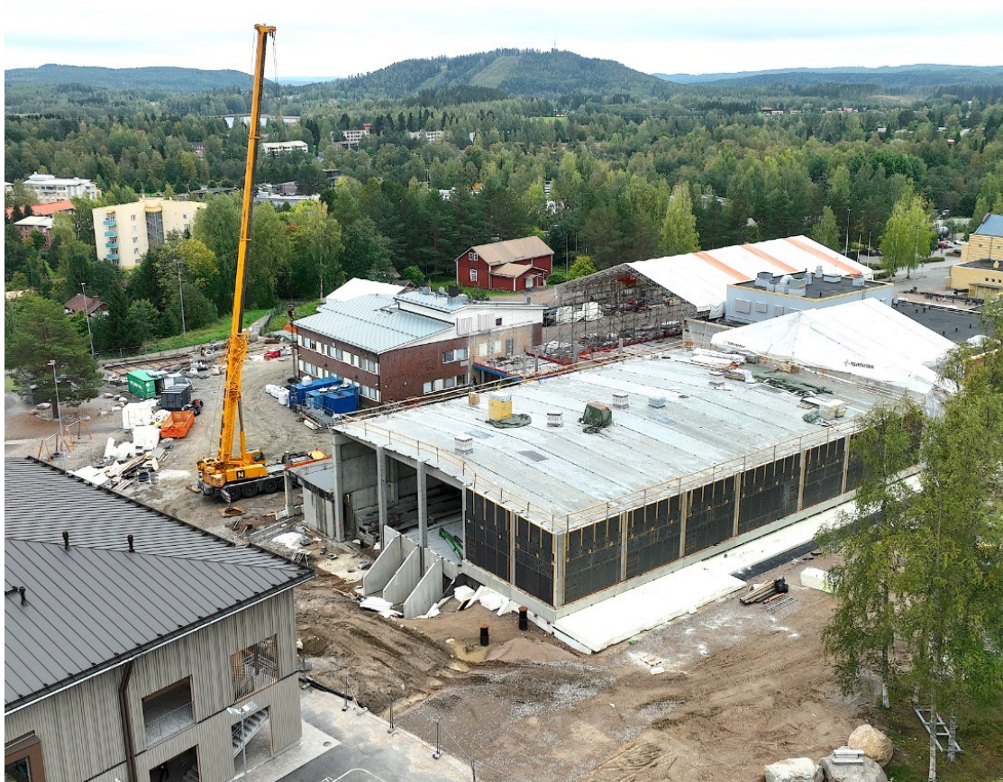
Kuva 6. Työmaan muuttuvat olosuhteet (Jalon.)
