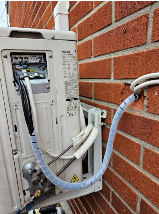
KUVA 8. Sisälle vietävät johdotukset.
