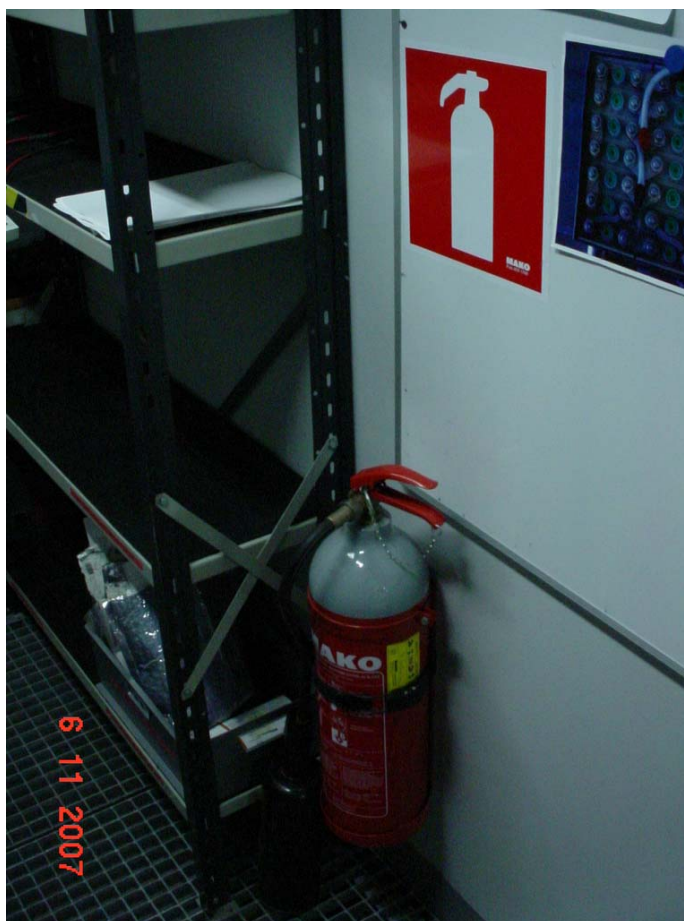
Kuva 13 Palosammuttimen paikka ja merkinnät korjaamotilassa.
