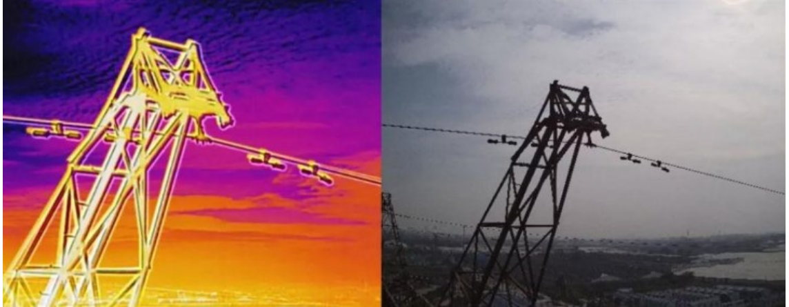
Kuvio 6. Dronen lämpökameralta ja normaalikameralta saadut kuvat voimalinjasta (UAV for Drone 2019).
