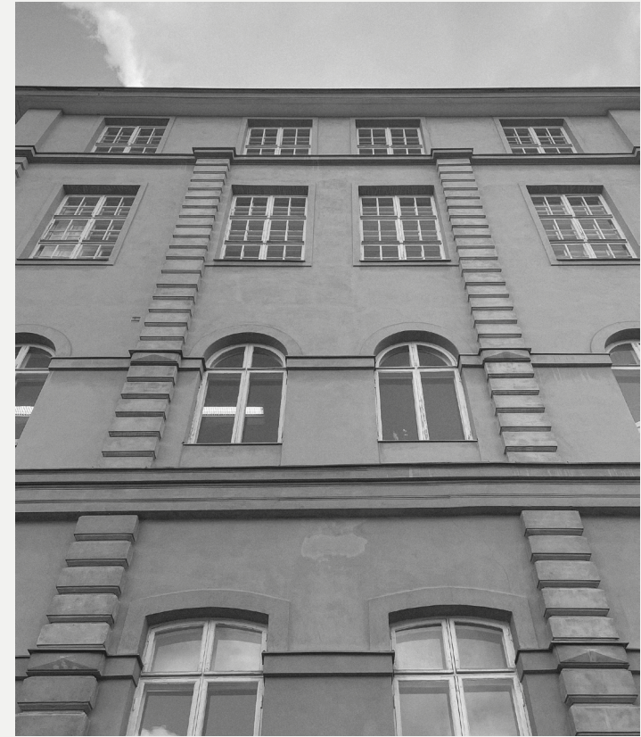
Kuva 1. Taiteen talon rakennus (Kuva: Nora Tuomi)
