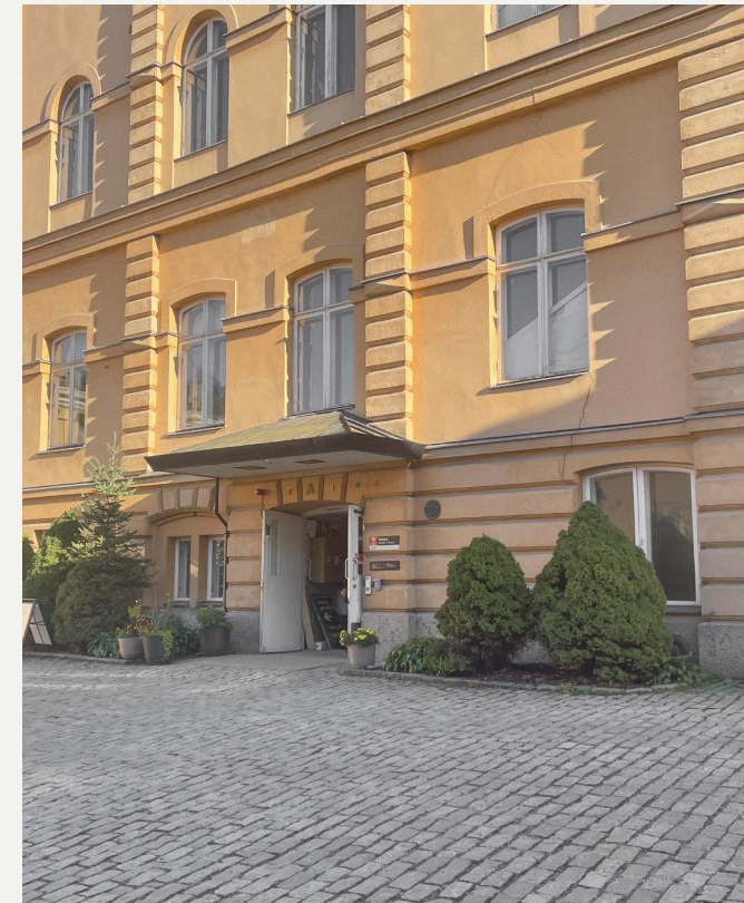
Kuva 2. Taiteen talon rakennus (Kuva: Nora Tuomi)
