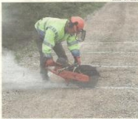
Induktiosilmukat asennetaan neljälle valtion omistamalle metsäautotielle. Kuvassa Reijo Onikki.
