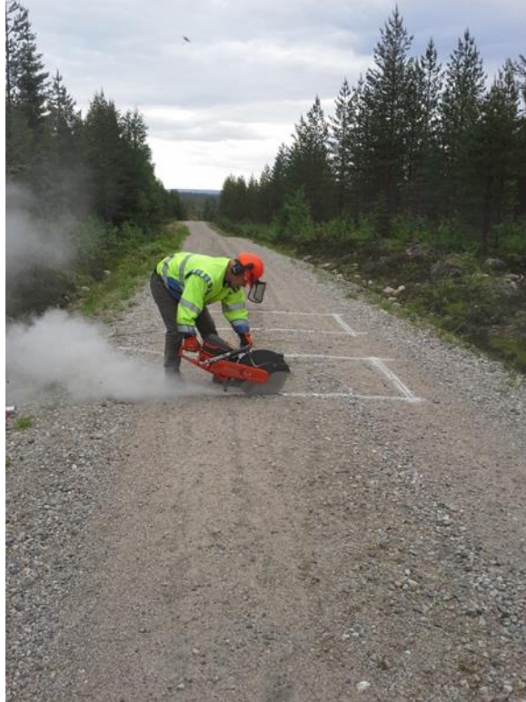
Kuva 4. Laskuriin kuuluvan induktiosilmukan asennus Jaappaassa. Kuvassa Reijo Onikki
