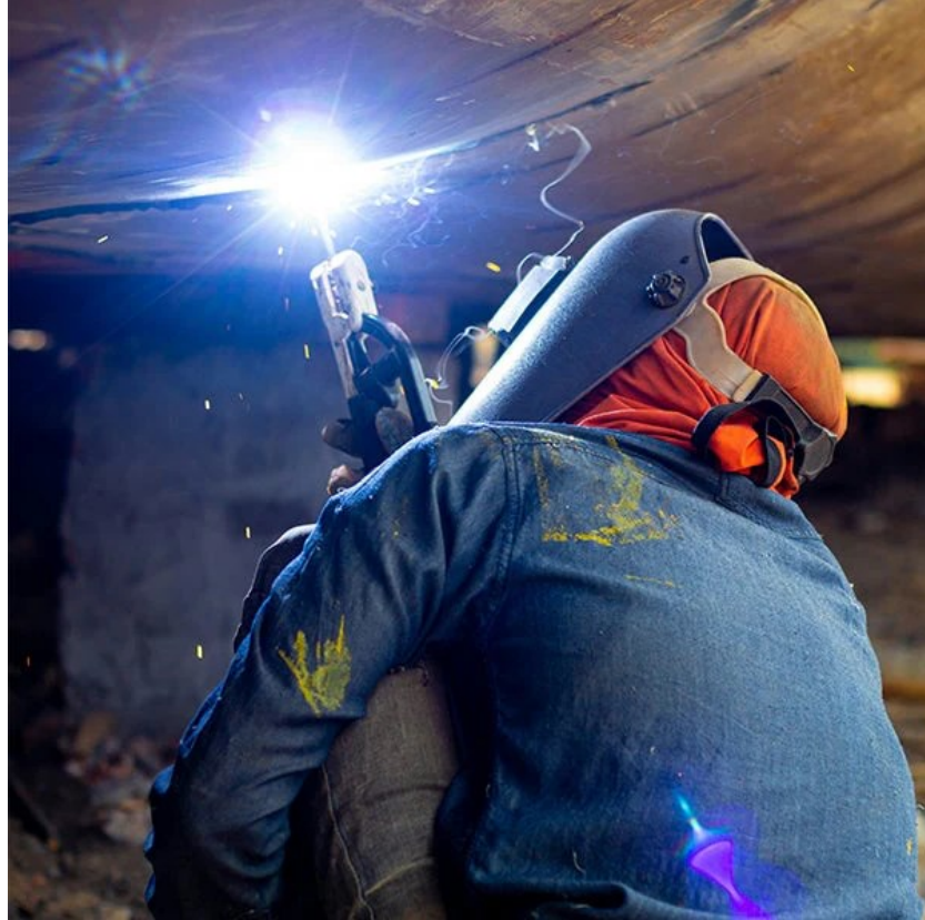
Kuvio 9. Asennushitsausta puikkokoneella (Yeswelder 2024)
