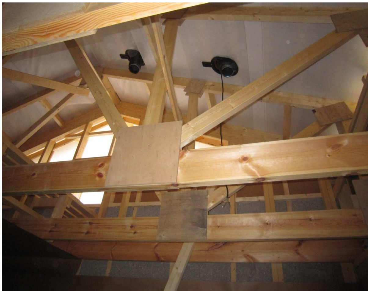
Kuva 7. Paikalla tehtyjä kattotuoleja (Sepponen 2014)
