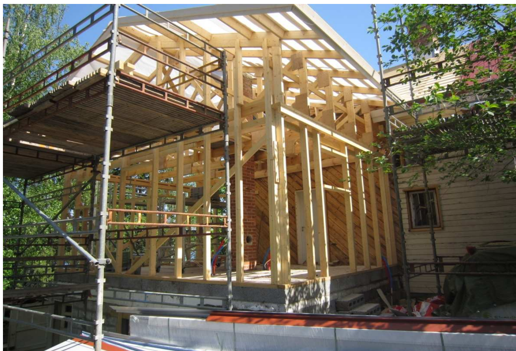
Kuva 6. Rakennuksen runkoa (Sepponen 2014)
