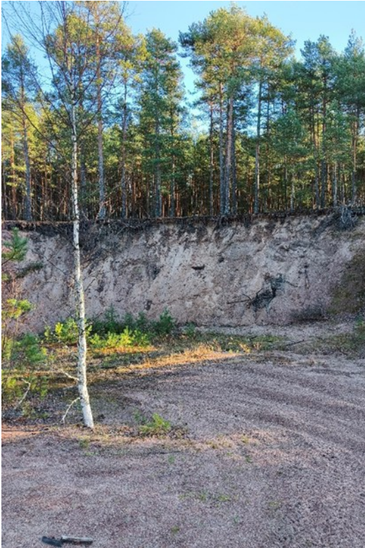
Kuva 19. Maanotto paikassa 37 oli paljon kulutusta ja montun reunat olivat jyrkät.
