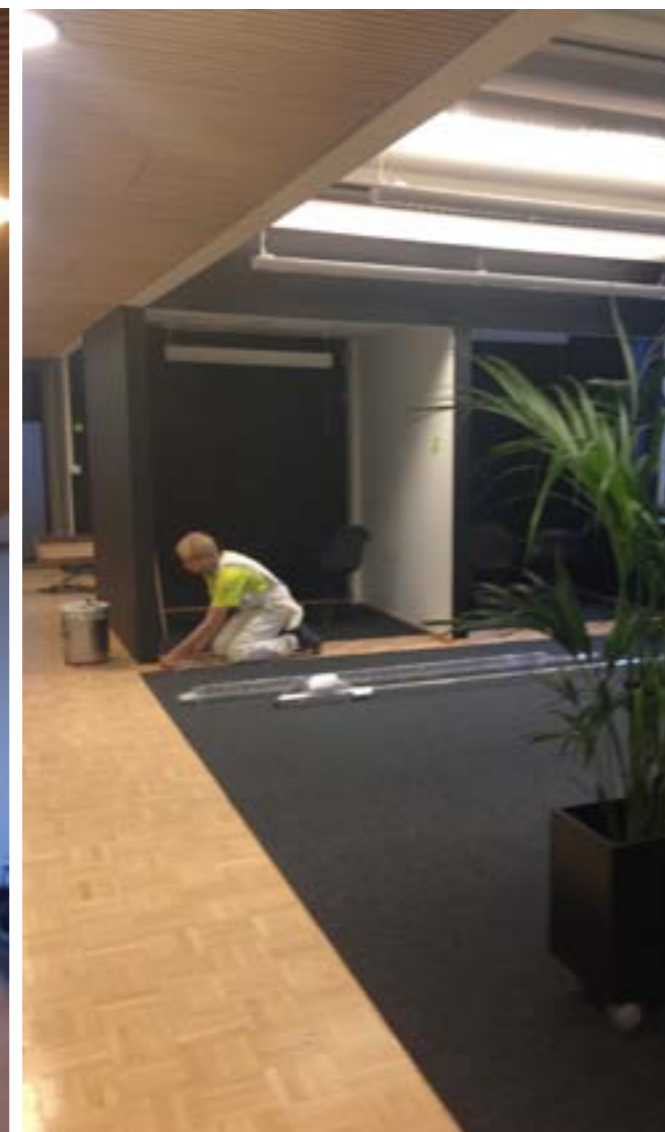
KOKOLATTIAMATTO ASENNETTIIN LOUNGE- JA VIRKISTYSALUEELLE.
