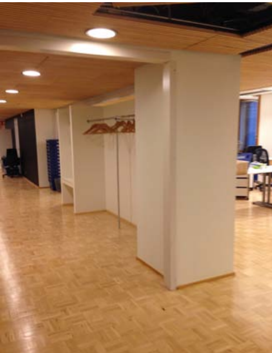
NAULAKKOTILA RAKENNETTIIN RAJAAMAAN KÄYTÄVÄÄ JA TOIMISTOA.
