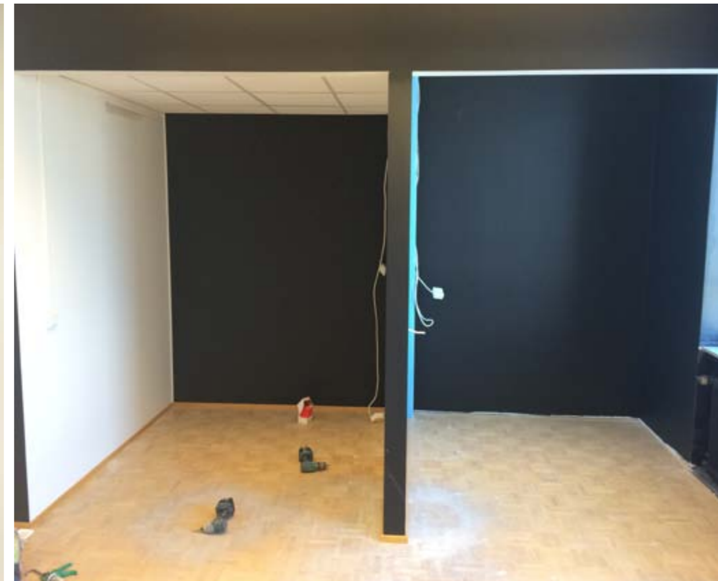
PUHELINKOPPIEN TAKASEINÄÄ SIIRRETTIIN YKSI IKKUNANVÄLI TAAKSEPÄIN JA VÄLI- JA SIVUSEINÄT RAKENNETTIIN.
