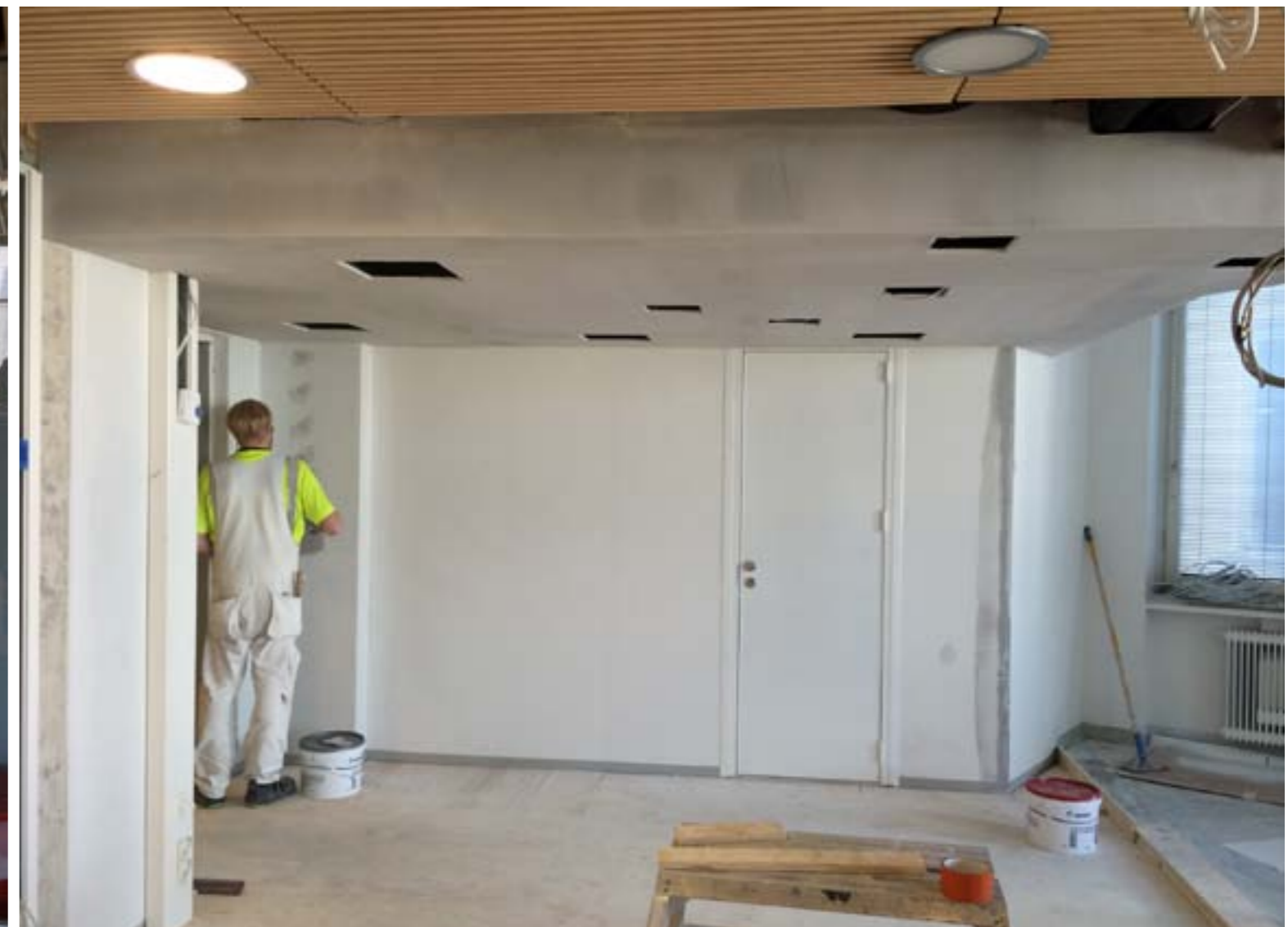
TAKATILAAN RAKENNETTIIN ALAKATTO PEITTÄMÄÄN TALOTEKNIikkaa. SAMALLA KATTOON ASENNETTIIN UPOTETTAVIA LISÄVALAISIMIA.
