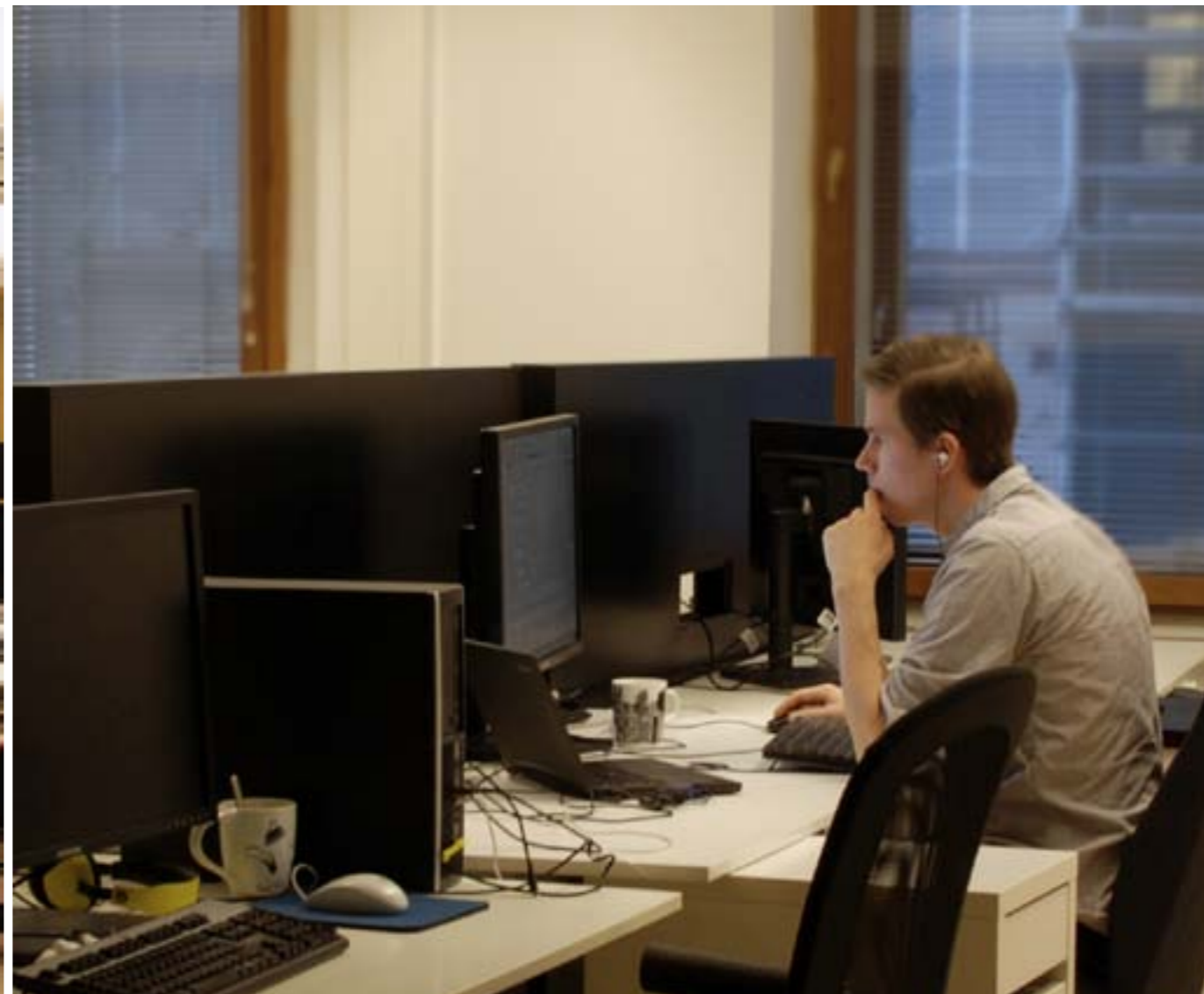
PÖMPELEITÄ ASENETTUINA TYÖPÖYTIEN VÄLIIN.
