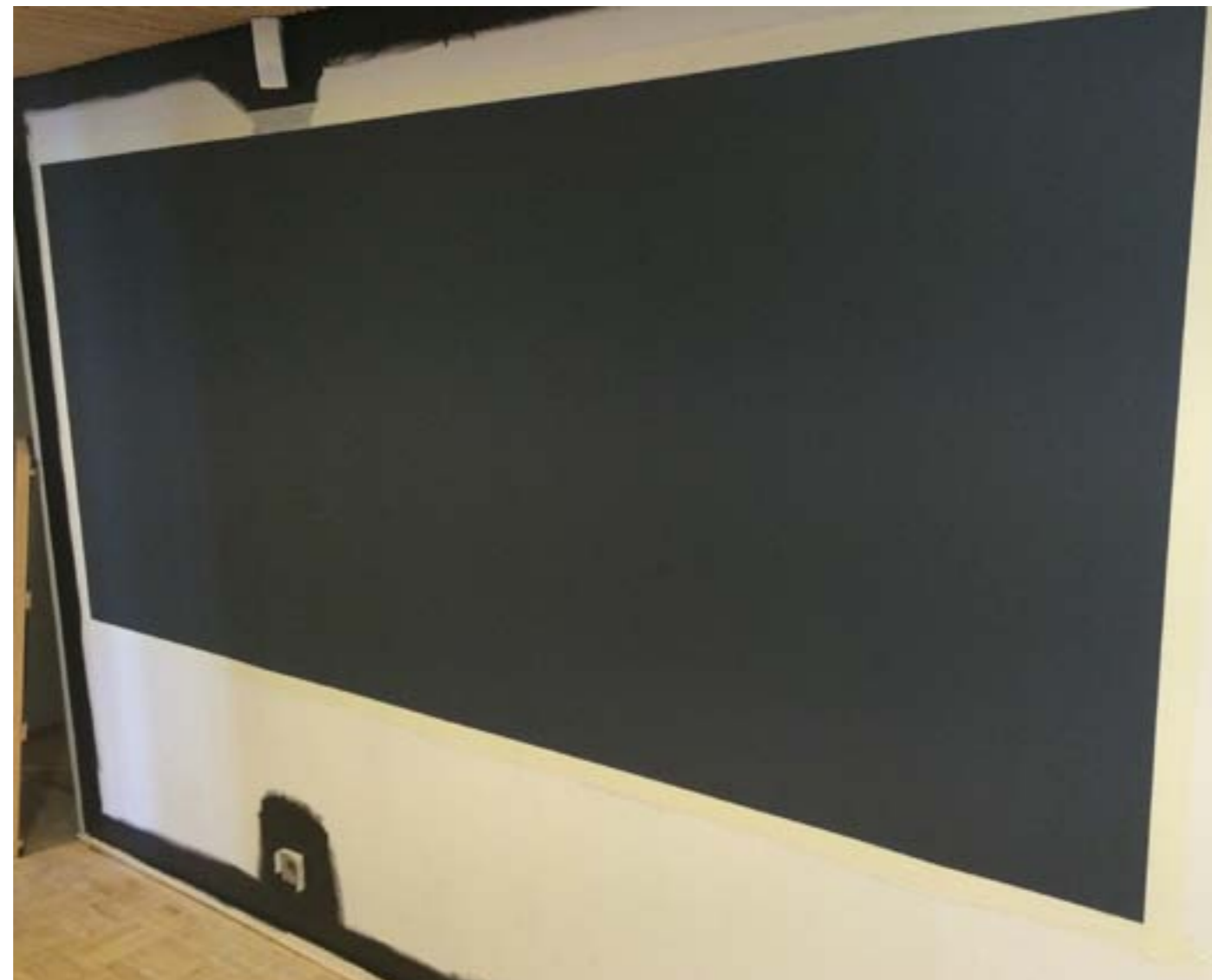
MAGNEETTIMAALI MAALATAAN PINTAMAALIN ALLE.
