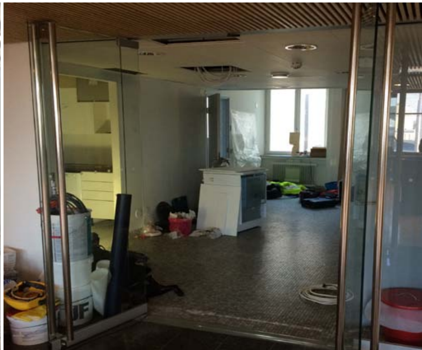
VANHA KEITTIÖ PURETTIIN JA TILALLE ASENNETTIIN KEITTIÖ, JOSSA ON NYT MYÖS UUNI PULLAN PAISTAMISTA VARTEN
