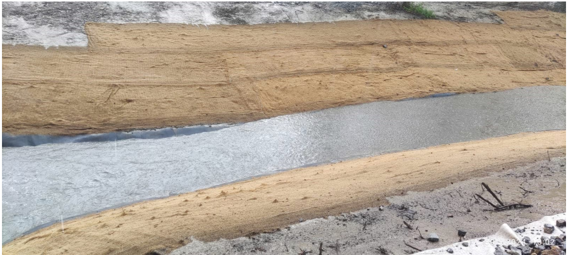
KUVA 15. Vedenpinta betonimaton ja kookoskuituisen siemeneroosiosuojamaton reunassa. (Kuva: Lassi Hannula)
