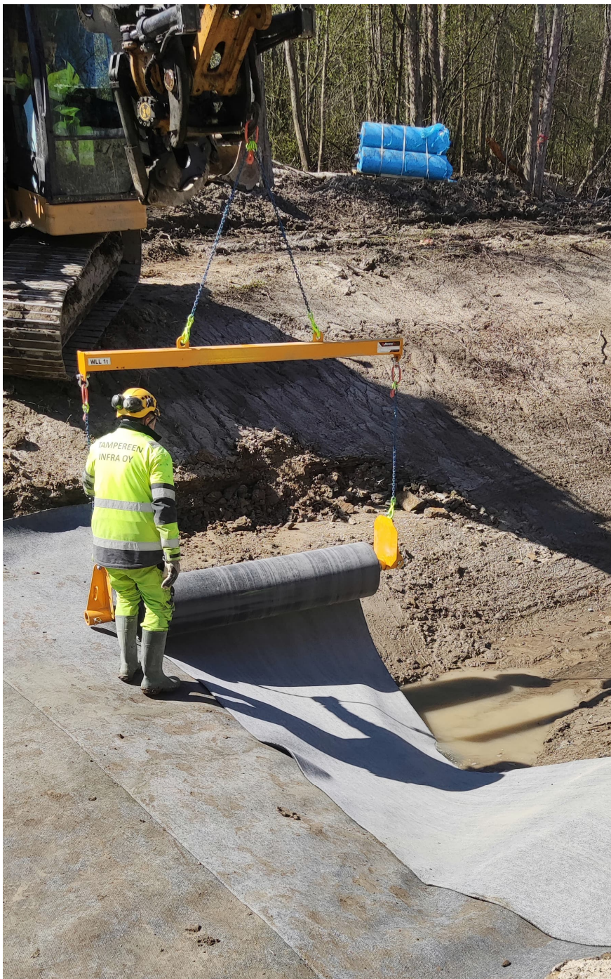
KUVA 11. Betonimaton levitys ojaan. Taustalla olevat siniset rullat ovat avaamattomia betonimattorullia (Kuva: Lassi Hannula)
