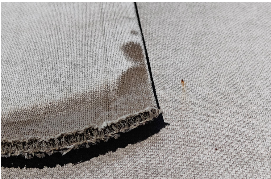
KUVA 6. Edelliskesänä asennetun betonimaton asennusvaiheessa leikattu reuna sekä tehtaalla tehty reuna. (Kuva: Lassi Hannula)
