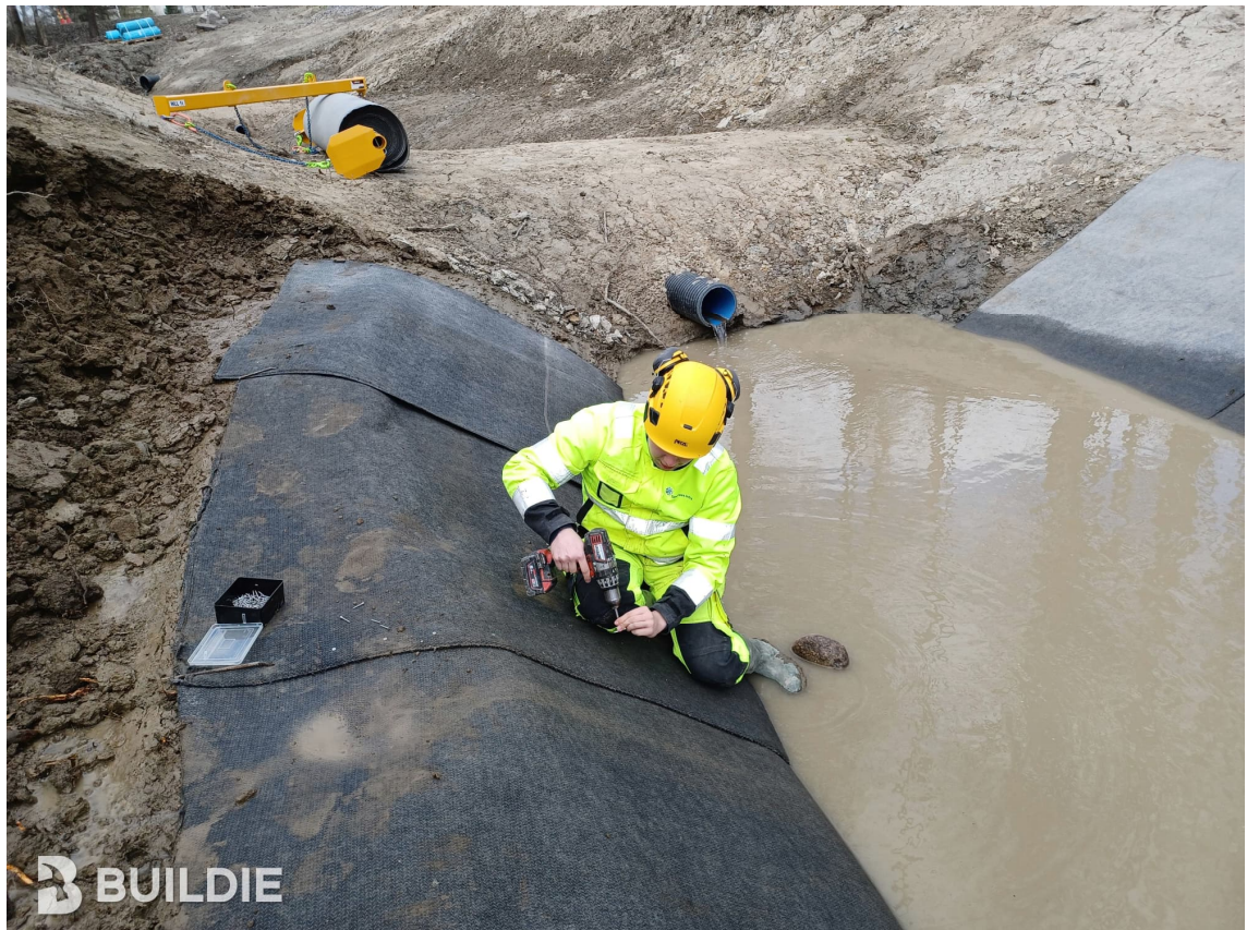
KUVA 10. Betonimaton ankkurointi maahan ja liittäminen toisiinsa. (Kuva: J-P Mäkinen).
