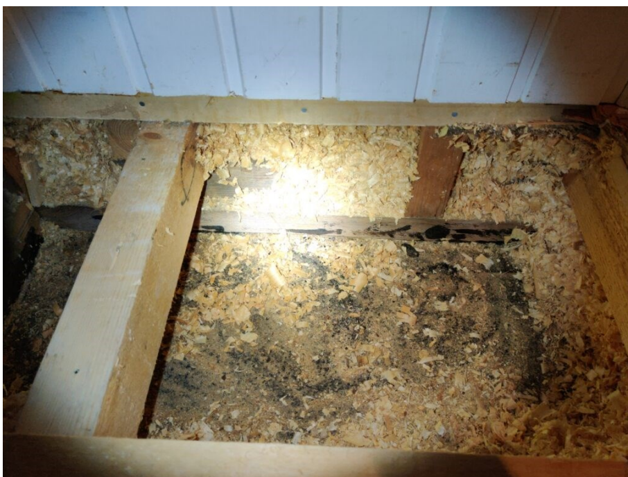
Kuva 2. Betonilaatan päältä alkava puurunkoinen väliseinä (Käyhkö, 2024).
