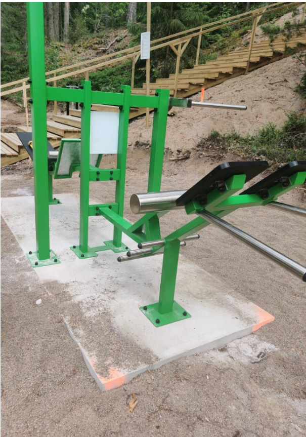
Kuva 4. FITX2-laitteen perustukset (Keckman, 2024).
