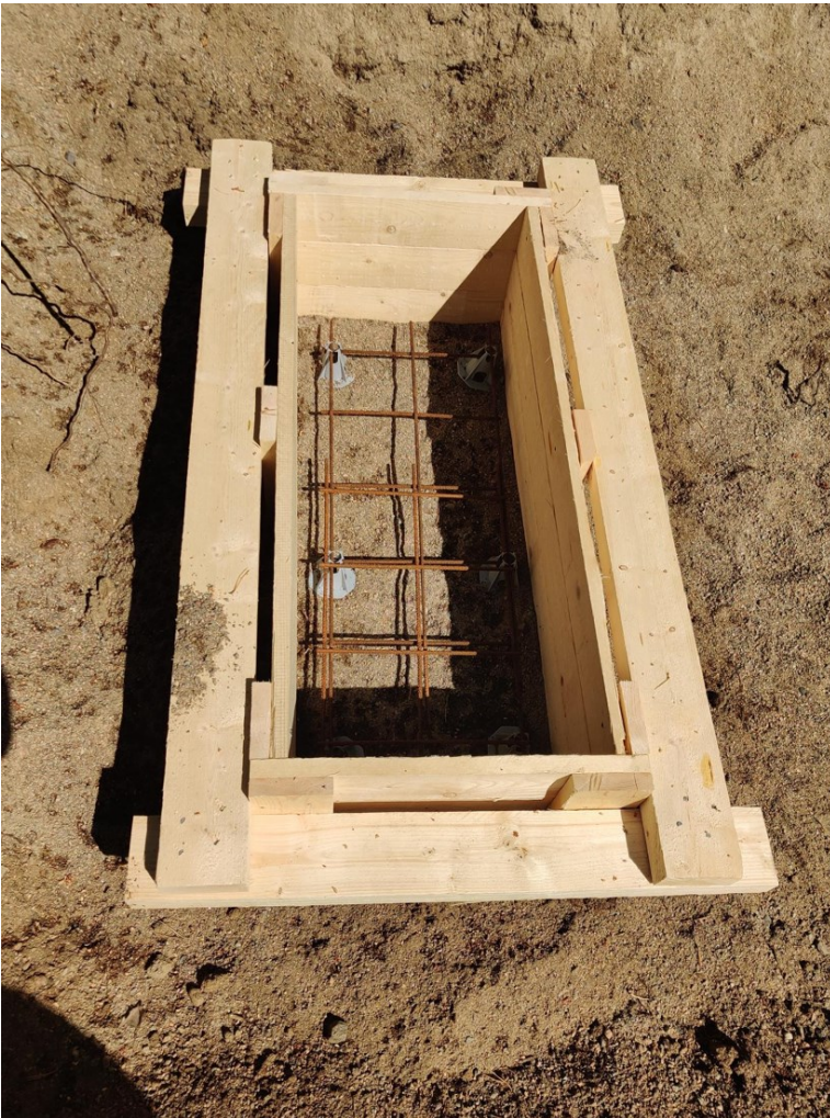
Kuva 2. Punnerruskeskuksen muottityötä (Keckman, 2024).
