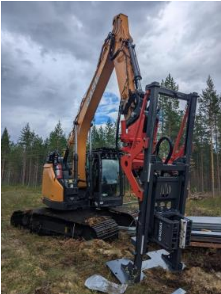
KUVA 5. Movax SGL-15 paalutuskone kaivinkoneessa (Kuva: 3Flash Finland Oy)
