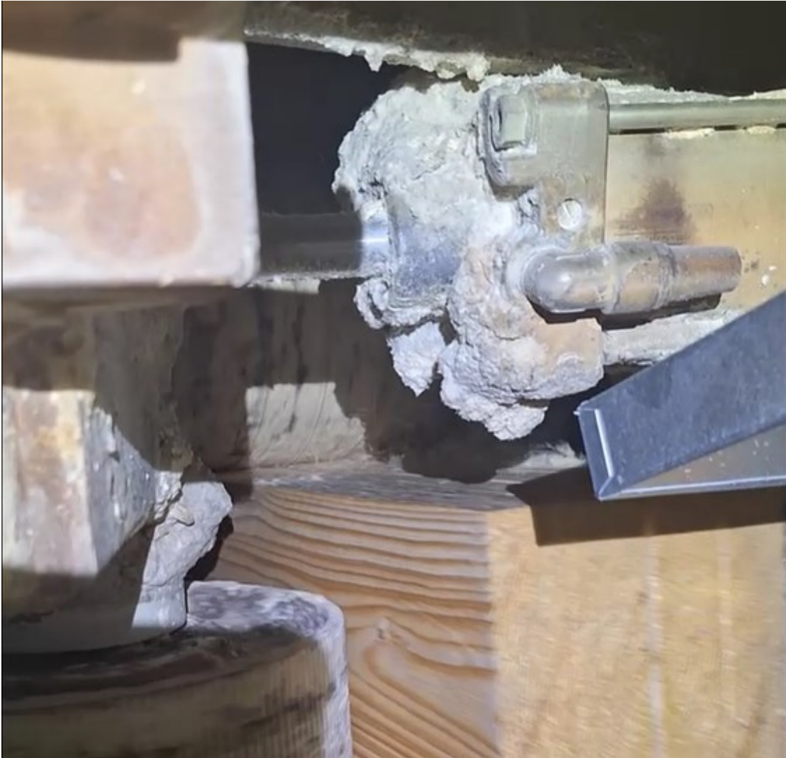
Kuva 29. Pelkanpuhallin puhaltaa kohti ulosvetoteloja
