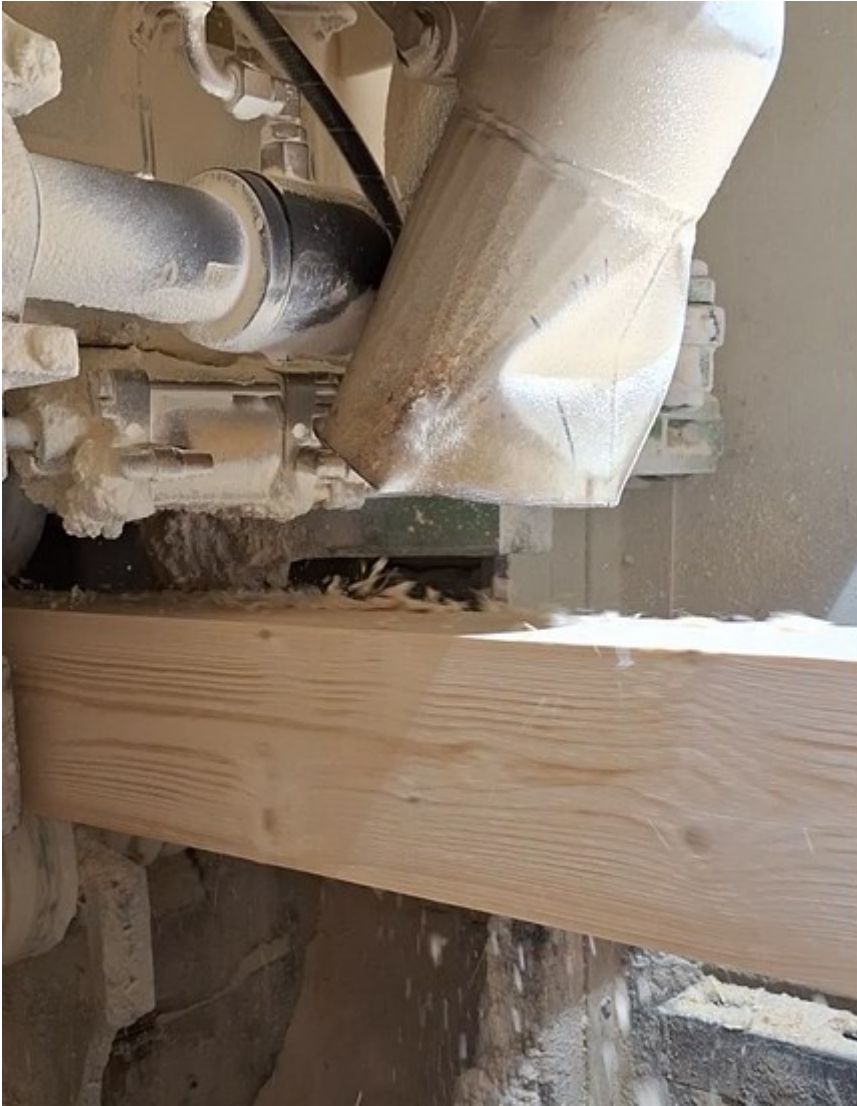
Kuva 19. Pelkan puhallin ennen muutoksia
