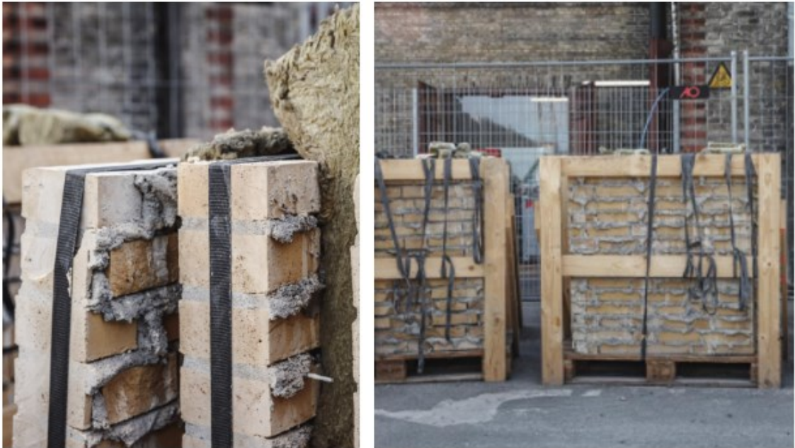
Kuva 10. Puretut tiiliseinäelementit. (Lähde: Lendager, 2024).
