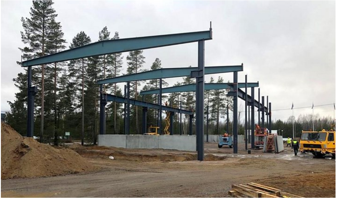
Kuva 3. Runkorakenteiden asennusta uuteen käyttökohteeseen. (Lähde: Suvi, 2023, s. 20).
