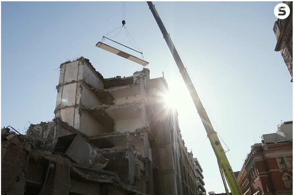
Kuva 12. Ontelolaattojen ehjänäpurku. (Lähde: Skanska Norja, 2024)
