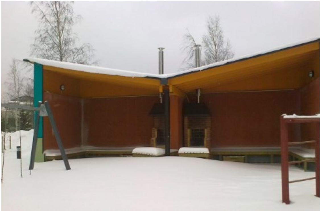
Kuva 4. Uudelleenkäytetyistä seinäelementeistä tehty grillikatos, Raahen. (Lähde: Ying Zhu 2022, 25).
