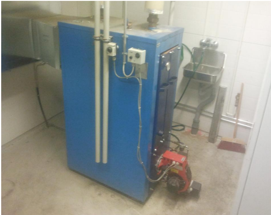
Kuva 13. Toimistorakennuksen öljylämmityskattila.
