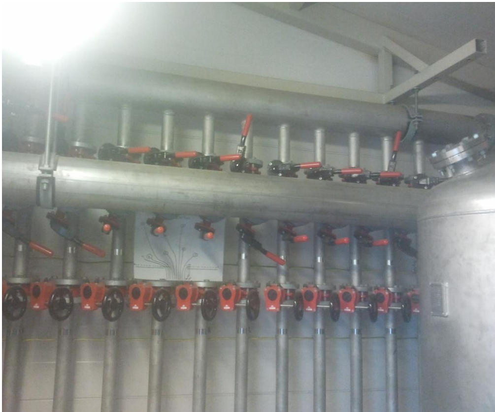
Kuva 2. Kaasunkeräysputkistoa mikroturbiinilaitoksella.
