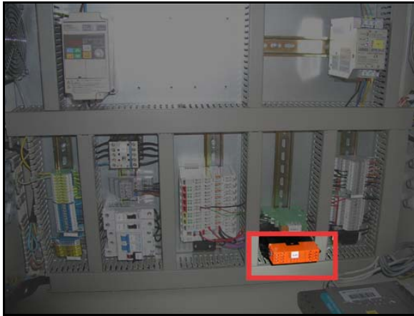
Kuva 2.13 Sähkökaapin turvarele
