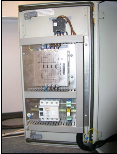
Kuva 2.4 Sähkökaapin 230V:n ovi valmiina
