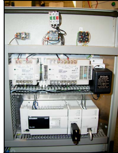
Kuva 2.5 Uusi logiikka kytkettynä paikoilleen
