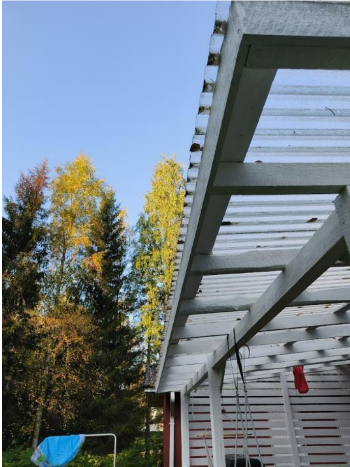
Kuvio 2. Kuntotarkastettavan rakennuksen terassin räystääs
