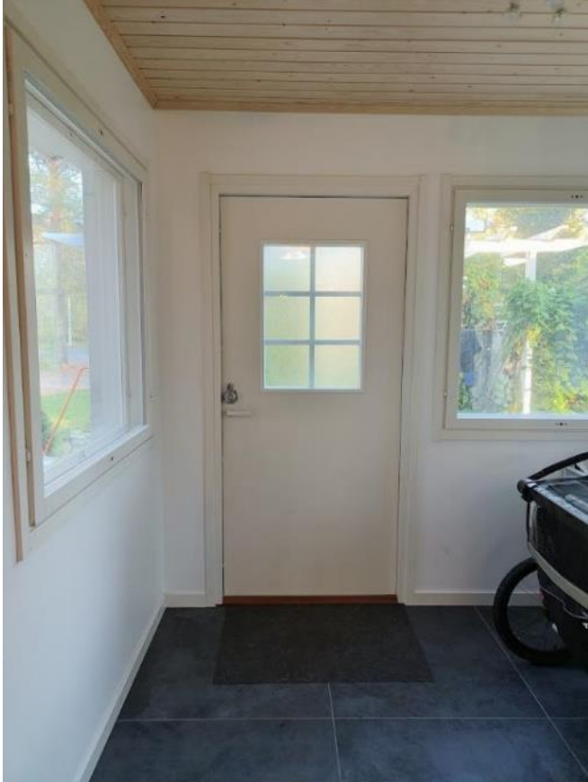
Kuvio 6. Kuntotarkastettavan rakennuksen remontoitu eteinen
