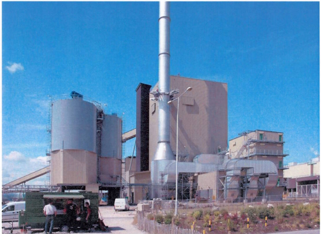
Kuva 4. Metso Powerin toimittama voimakattila UPM:n tehdasalueella Ranskassa. KPM-Engineering Oy:n tehtäviin kuului teräsrakenteiden sekä prosessikanaviston suunnittelu.
