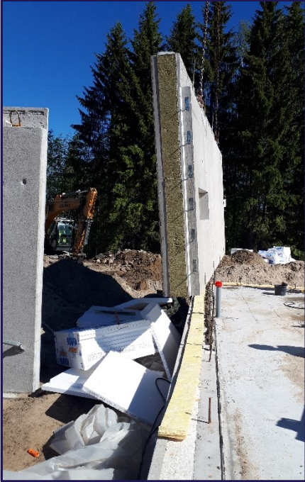
Kuva 6. Sandwich-ulkoseinäelementin asennus (Kananen, 2024, CC BY-NC-SA).
