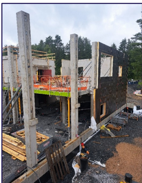
Kuva 3. Kahden kerroksen korkuiset pilarielementit asennettuna (Kananen, 2024, CC BY-NC-SA).
