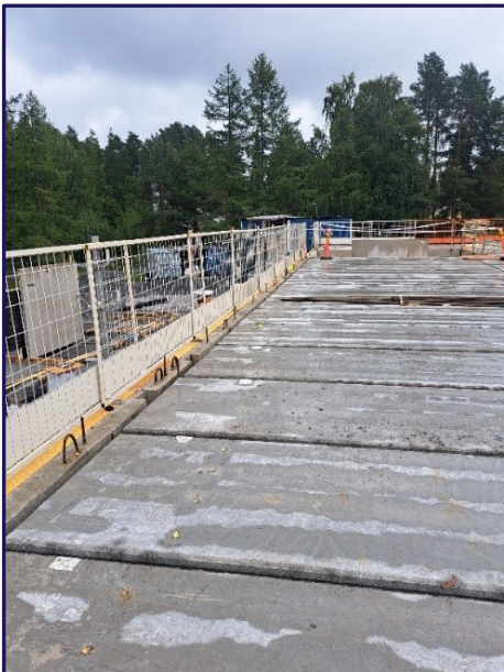
Kuva 7. Holvin ontelolaatat ja putoamissuojaus asennettu (Kananen, 2024, CC BY-NC-SA).
