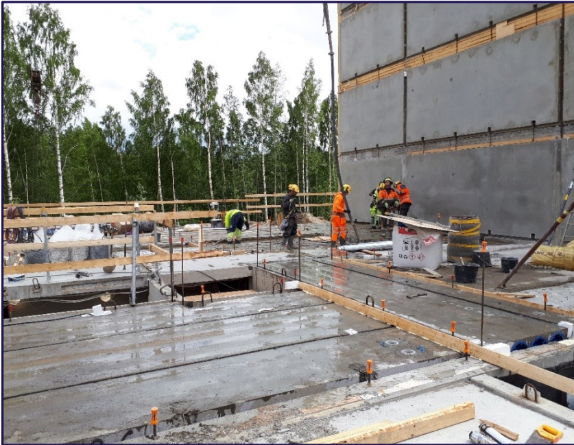
Kuva 8. Holvikentän juotosvalu betonipumppuautolla (Kananen, 2024, CC BY-NC-SA).
