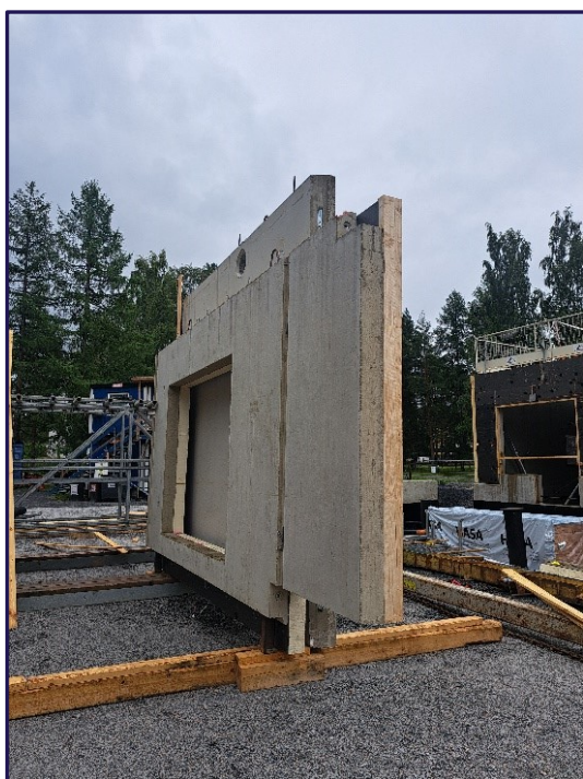
Kuva 2. Elementtifakkiin välivarastoitu kuori- ja väliseinäelementit (Kananen, 2024, CC BY-NC-SA).
