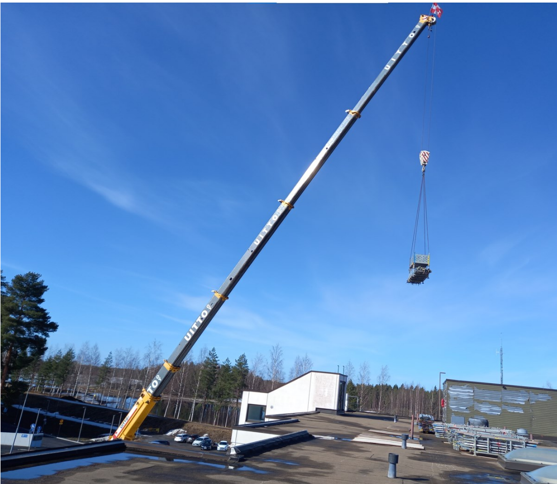
Kuva 2. Telineosien nosto katon yli. (Ranta, 2024)
