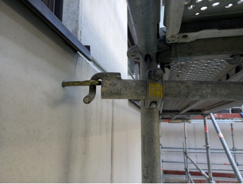
Kuva 4. Telineen ankkurointi betoniseinään (Ranta, 2024).
