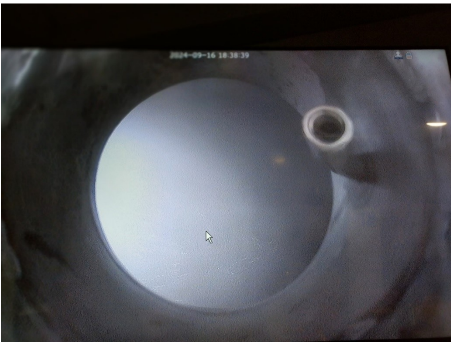
KUVA 5. Näkyvyys liuotuksen alkuvaiheessa.
