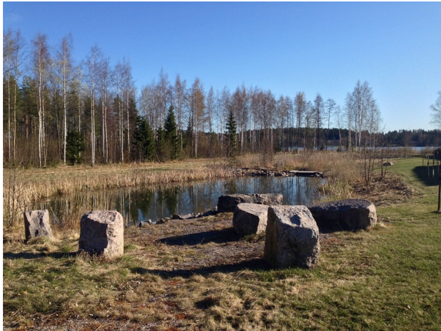
KUVA 12. Rakennettu kosteikko hulevesien viivytykseen
