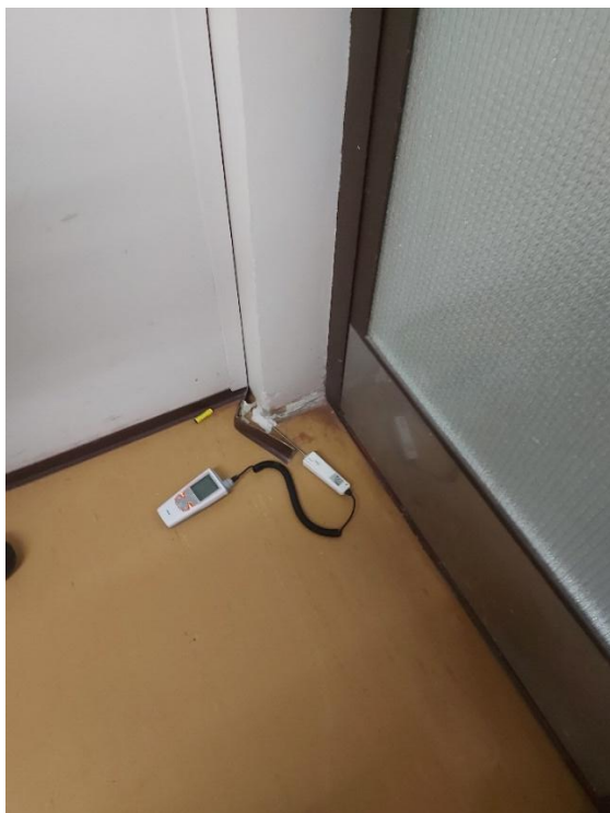
KUVA 12. Viiltokosteusmittaus suoritettiin lisätutkimuksena visuaalisesti havaitusta kohdasta. (Laakso 2024.)
