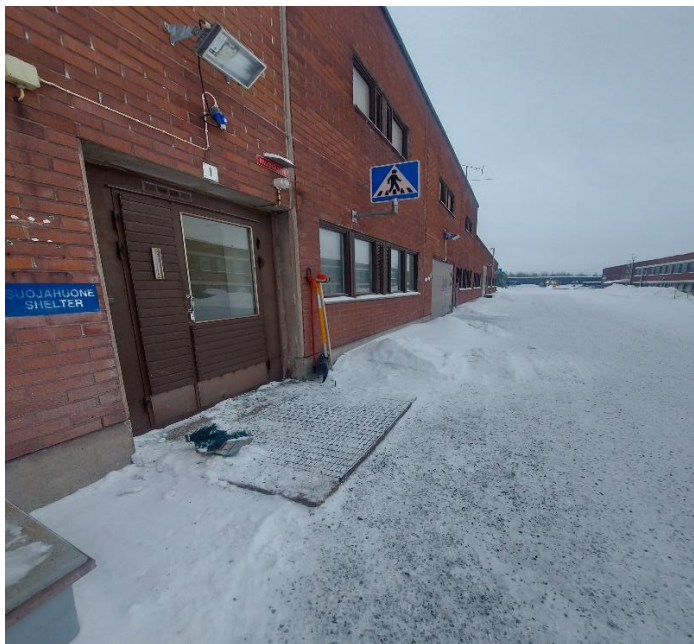
KUVA 1. Rakennuksessa alkuperäiset nauhaikkunat (Laakso 2024.)
