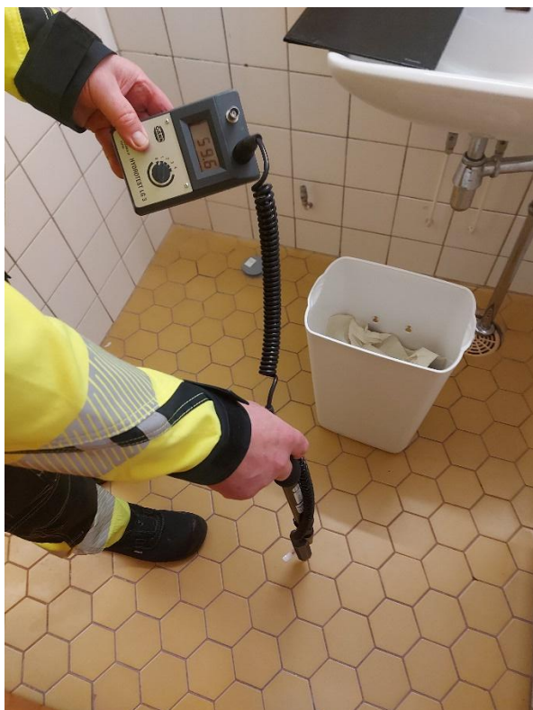
KUVA 11. WC- ja märkätilojen pintoja tutkittiin pintakosteuskartoittimella. (Laakso 2024.)
