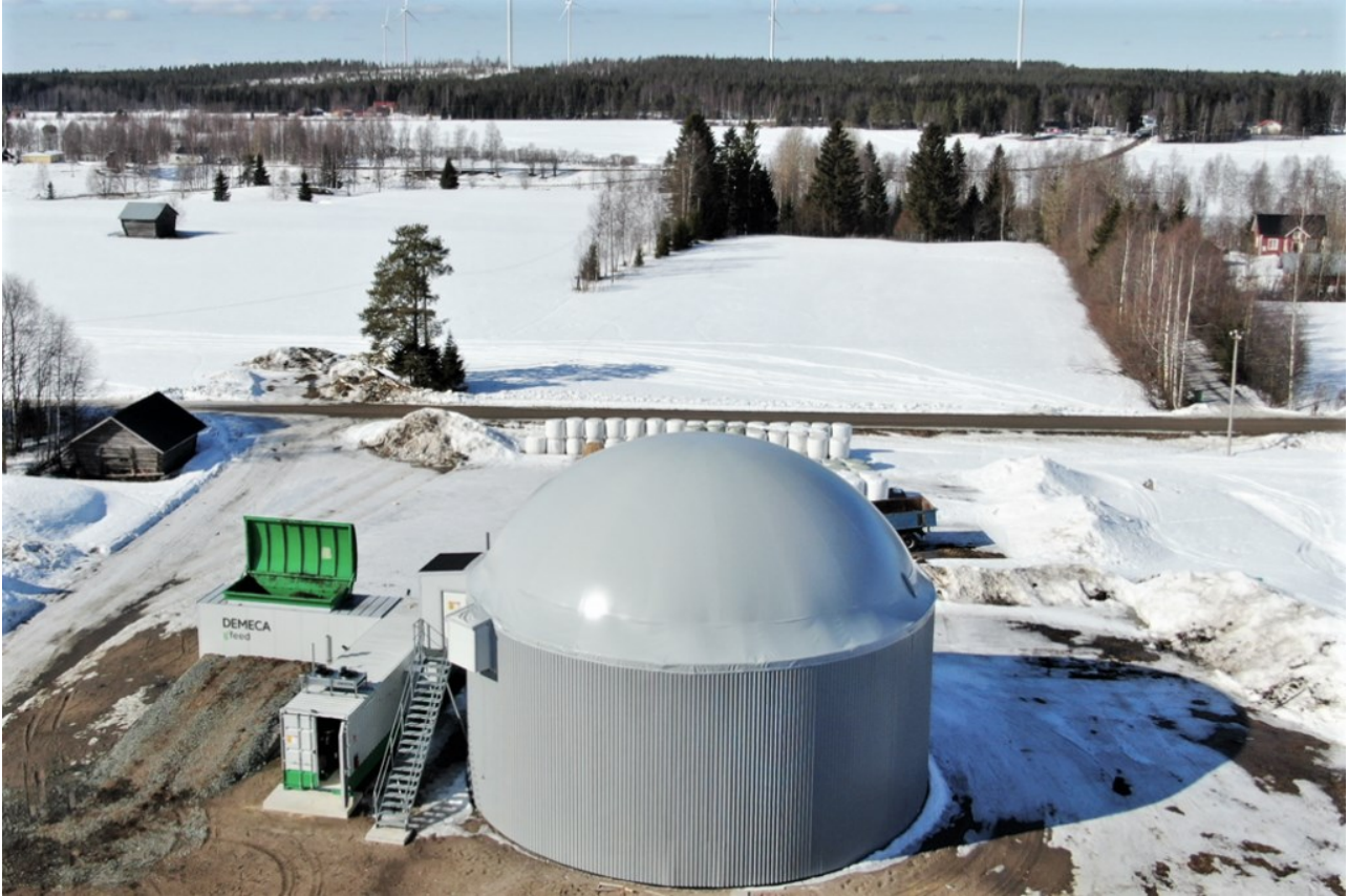
KUVA 1. Demeca Oy:n rakentama ja 2023 käyttöön otettu biokaasulaitos Jurvan tilalla Tervolassa. Reaktorin päällä oleva kupu toimii kaasuvarastona. (Kuva: Mikko Aalto.)
