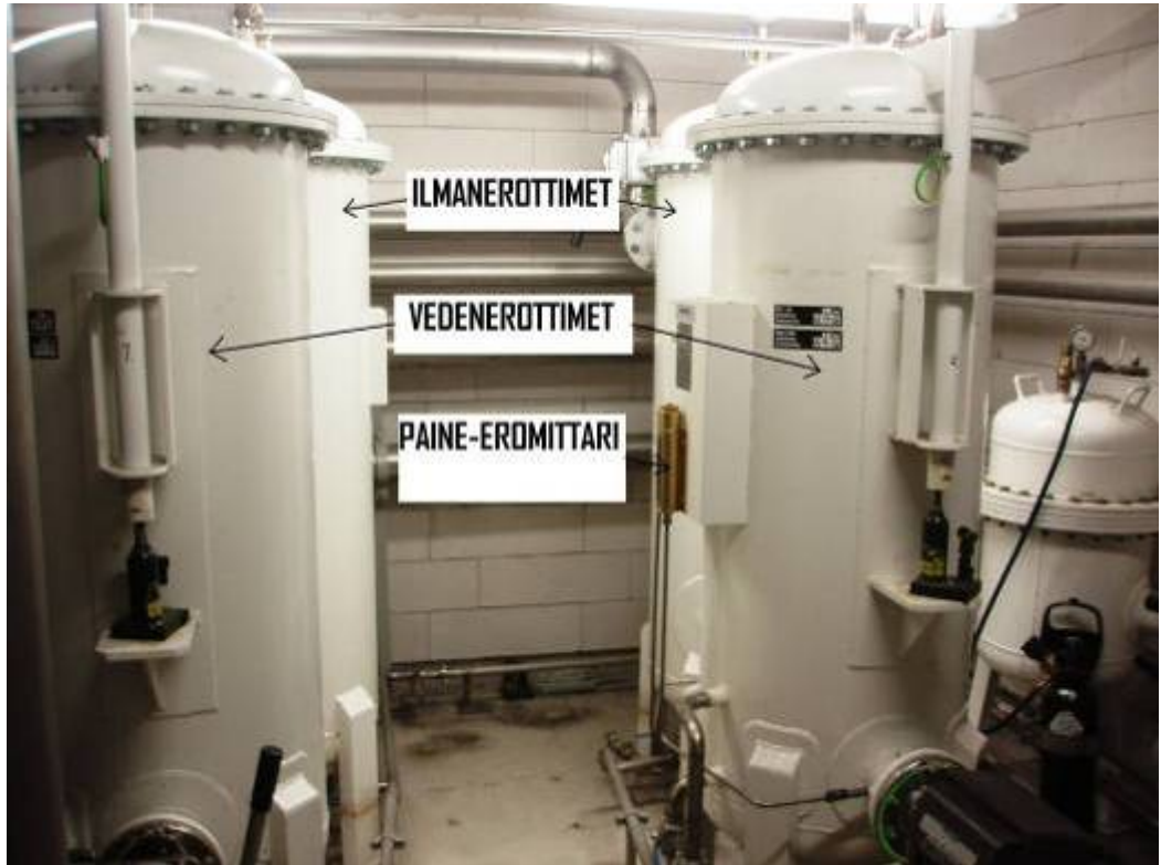
KUVA 15 Pumppaamon painelinjojen suodatinastiat
