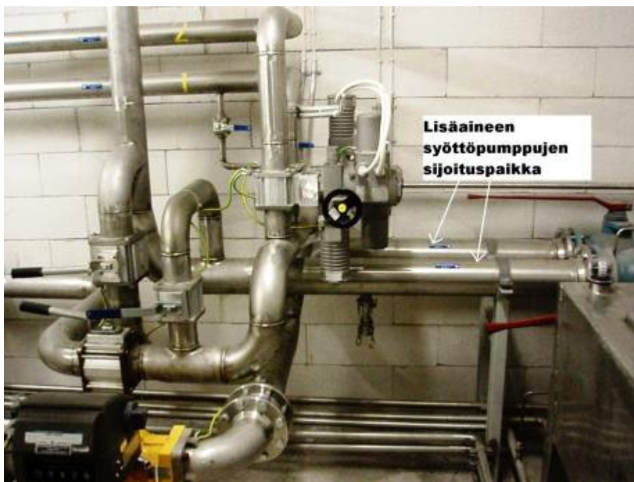
KUVA 29 Lisäainepumppujen sijoitus
