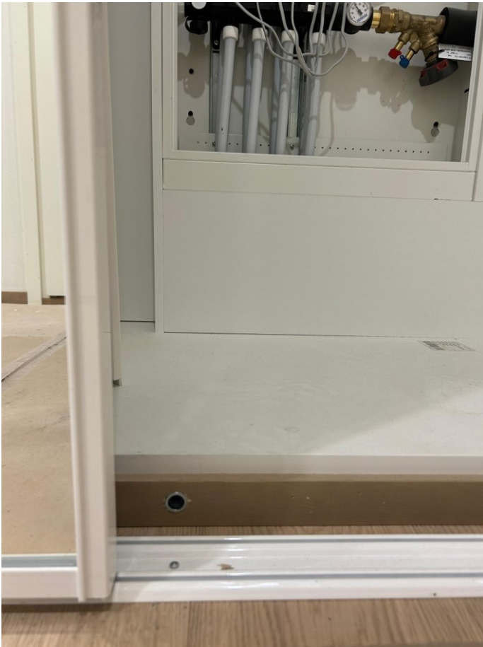
Kuva 11 Eteisen kaappiin sijoitettu jakotukkikaappi ja vuodonilmaisin (YIT, n.d.).
