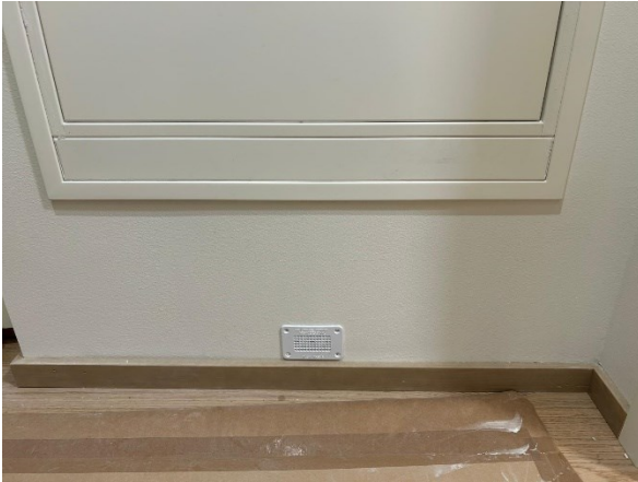
Kuva 11 Eteisen kaappiin sijoitettu jakotukkikaappi ja vuodonilmaisin (YIT, n.d.).
