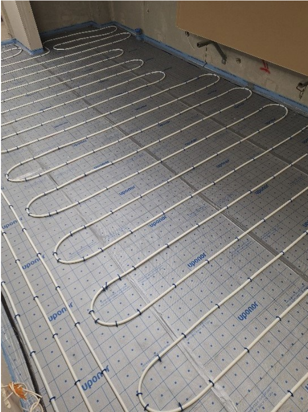
Kuva 22 Putkien kiinnitys (YIT n.d.).
