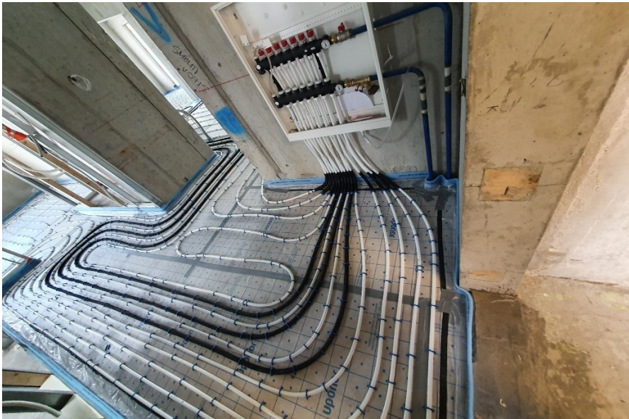
Kuva 14 Jakotukkikaapin sijainti ja korko (YIT, n.d.).
