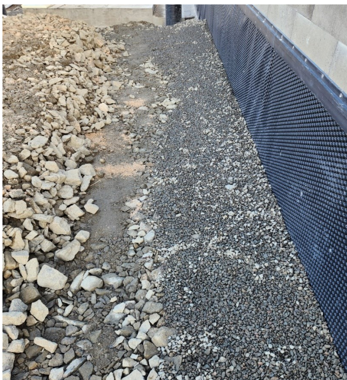
Kuva 300. Perusmuurin ulkopuolinen salaojituskerros ja ulkopuolen täyttöä
