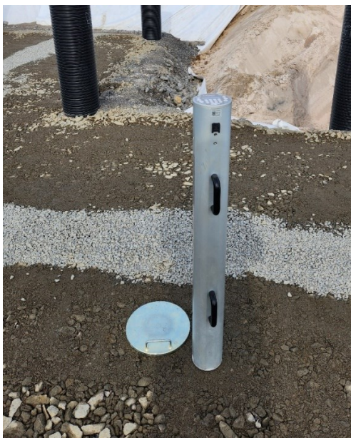
Kuva 18. Anturan alapuolinen rakennekerros # 0/55 ja salaojitusjohteet anturalinjan alitukseen # 8/16 sepelillä.
