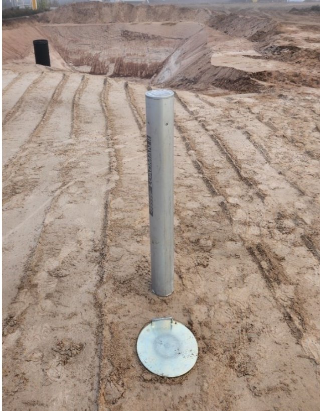
Kuva 22. Lopputäytön tiiviyssuhdemittaus Loadman II -laitteella
