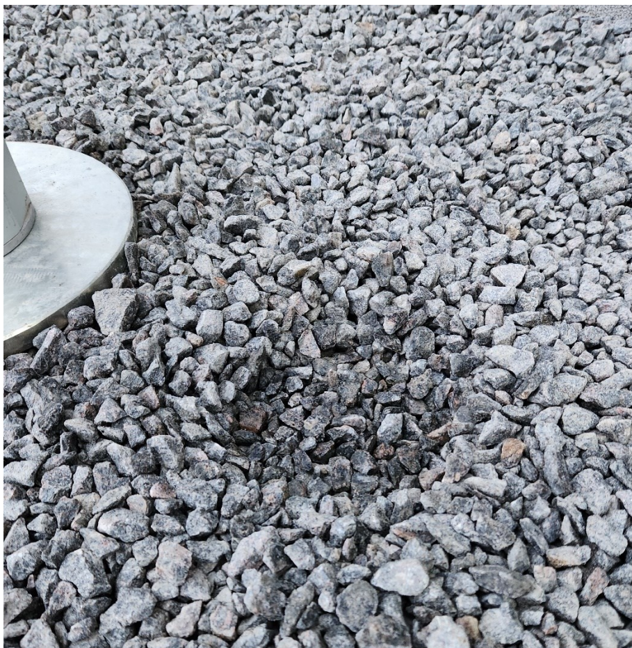
Kuva 33. Mittauspiste 3 132 mm:n kuormituslevyllä suoritetun kapillaarikatkokerroksen tiiviyssuhdemittauksen mittaussarjan jälkeinen painauma.
