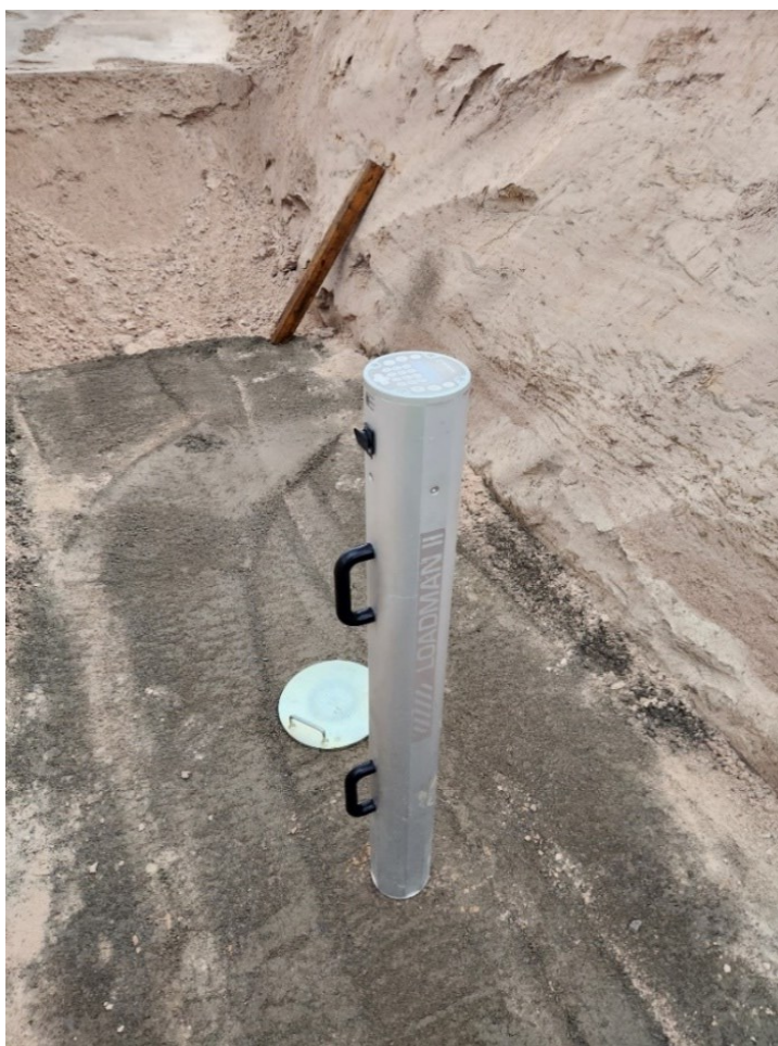
Kuva 14. Asennusalusta KaM # 0/16. Kantavuus- ja tiiviyssuhdemittaus Loadman II -laitteella 132 mm:n kuormituslevyä käyttäen.
