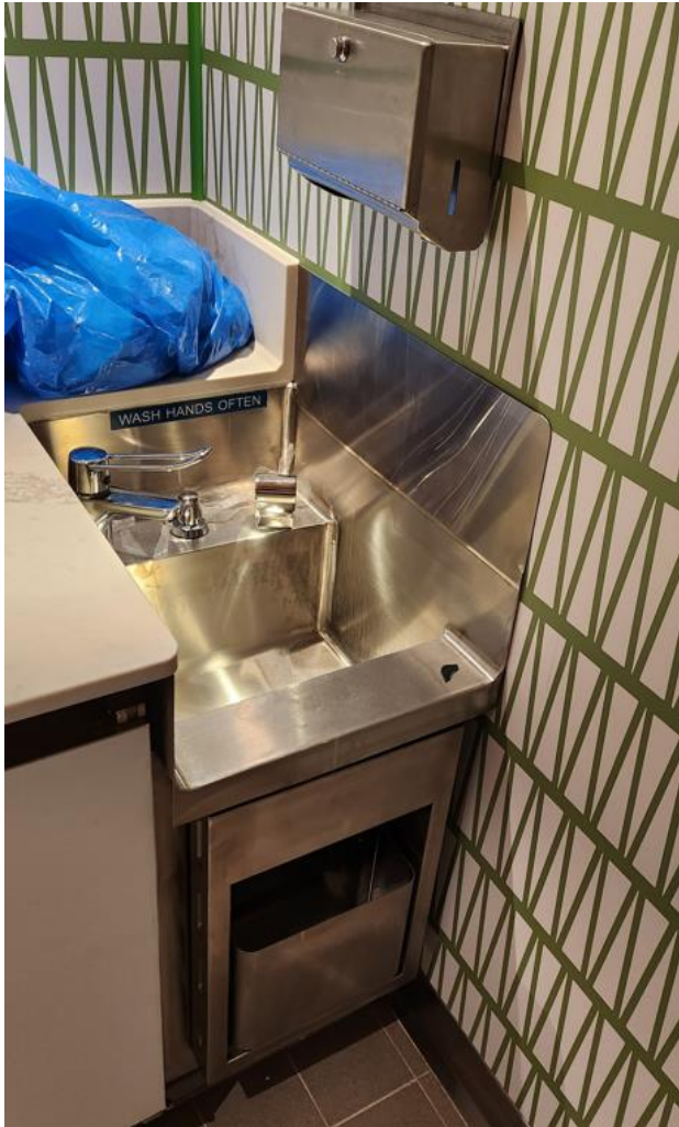
Kuva 19. Metalliasennus Huuhka Oy, 2023.
