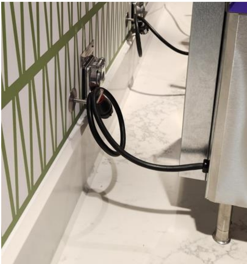
Kuva 10. Metalliasennus Huuhka Oy, 2023.
