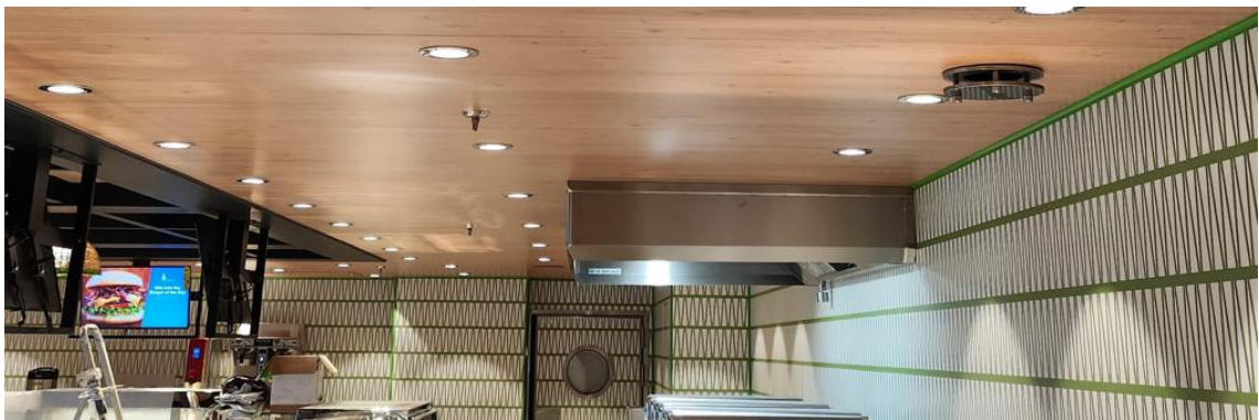
Kuva 22. Metalliasennus Huuhka Oy, 2023.
