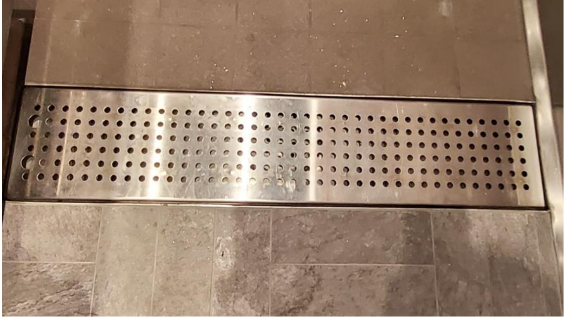
Kuva 7. Metalliasennus Huuhka Oy, 2023.
