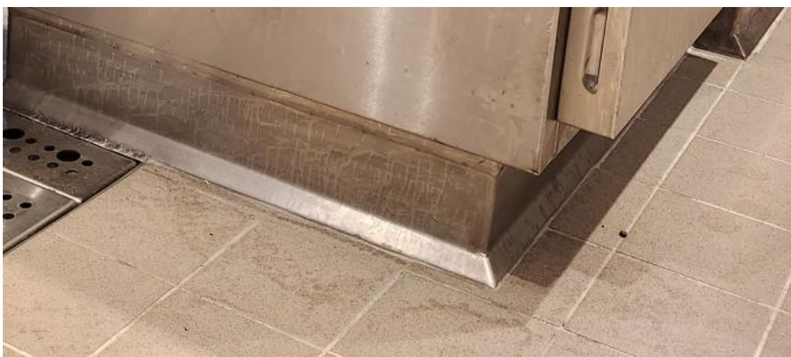
Kuva 5. Metalliasennus Huuhka Oy, 2023.
