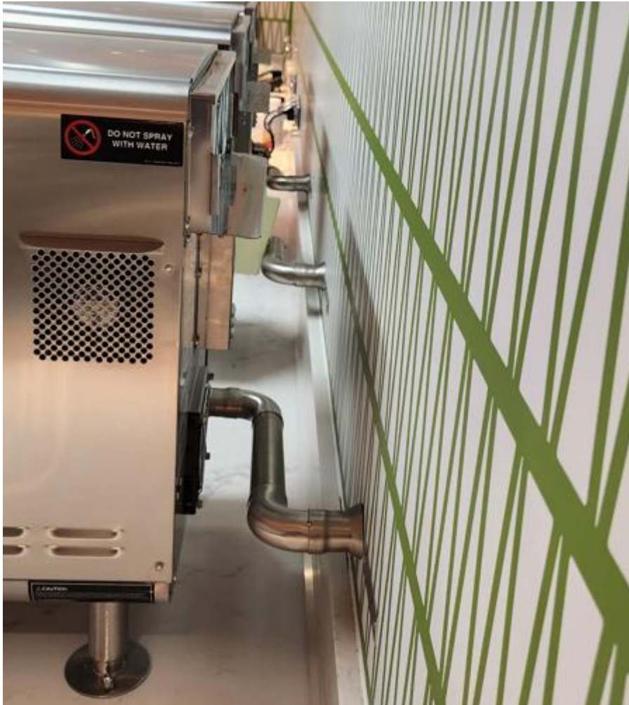
Kuva 11. Metalliasennus Huuhka Oy, 2023.
