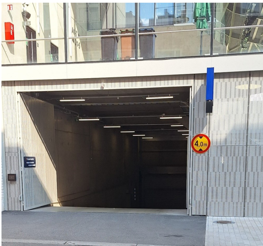
Kuva 7. Sisäänajo Tammelan stadionin huoltotunneliin, Tampere.
