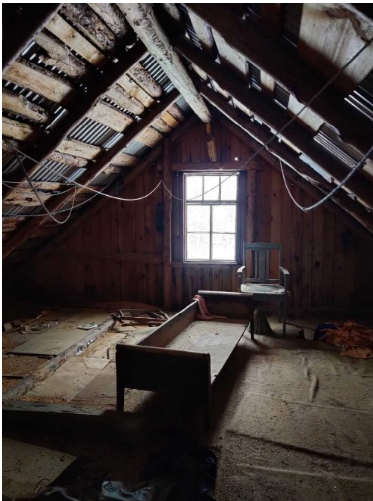
Kuva 7. Avoin yläpohja/ullakkotila (Korhonen 2024)
