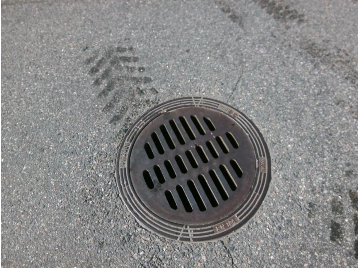
Kuva 21. Sadevesikaivo, ritiläkansi (Finavia, n.d.).
