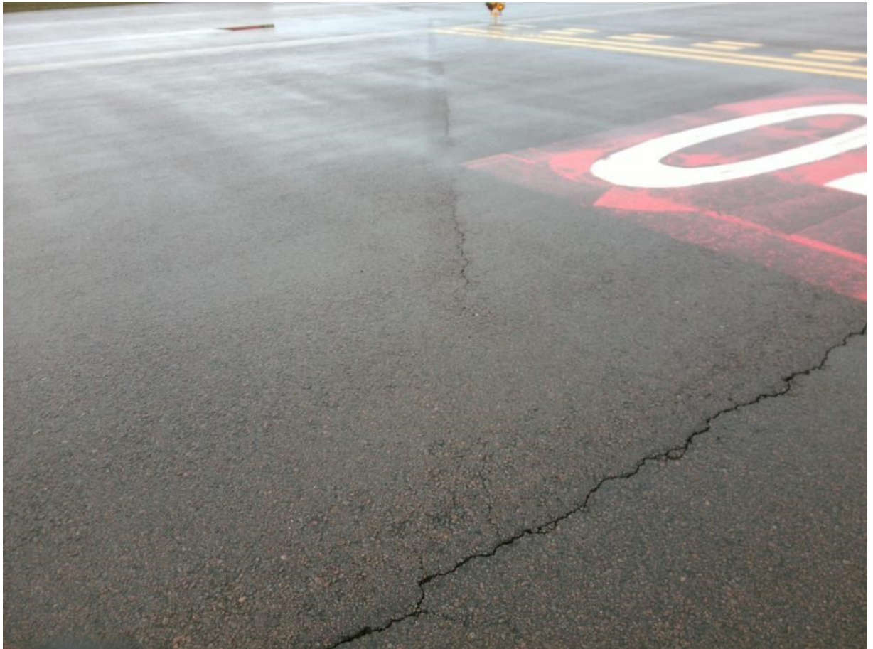
Kuva 7. Heijastehalkeamaa putkiuran kohdalla 2 (Finavia, n.d.).
