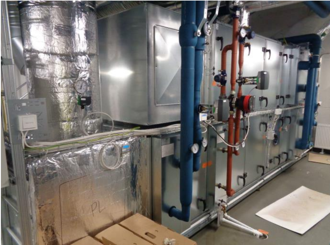
KUVA 11. Valmis ilmanvaihtokoneen ja oheislaitteiden asennus
