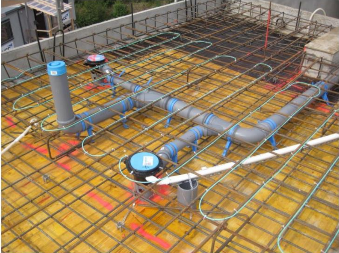
KUVA 6. Lattiakaivon ja viemäriin asennus paikallisvaluholviin (15, s. 14)
