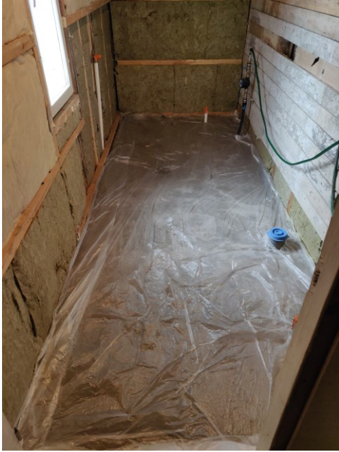
KUVA 21. Betonivalu peitetty liian nopealta kuivumiselta
