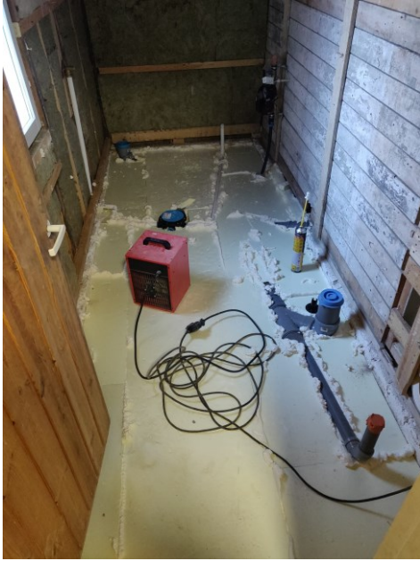
KUVA 18. Eristelevyjen saumoja täytetty uretaanivaahdolla
