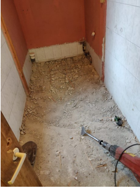
KUVA 14. Betonilaatan purku piikkaamalla
