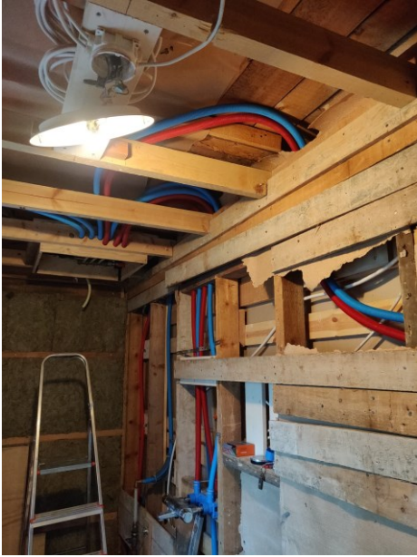
KUVA 24. Uudet käyttövesiputket asennettu rakenteisiin
