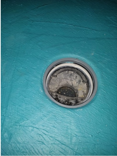
KUVA 28. Kaivon tiivistys kaivolaipalla
