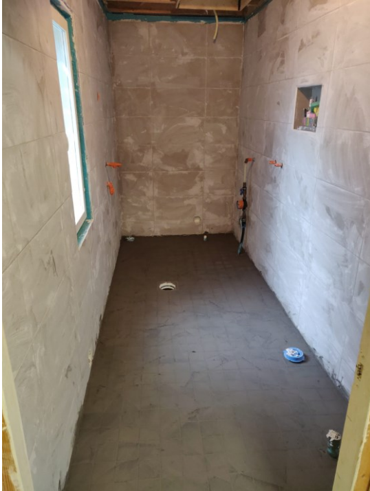
KUVA 30. Laattojen saumaus kuivumassa
