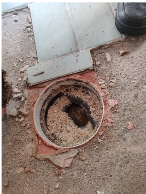
KUVA 9. Kylpyhuoneen kaivon alue
