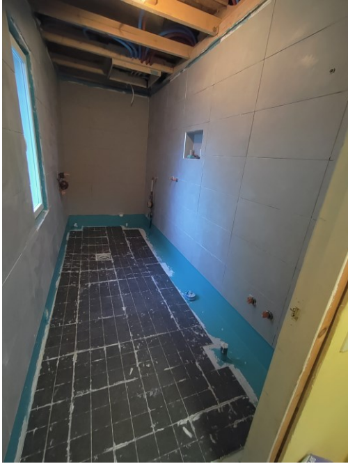
KUVA 29. Lattialaatoitus aloitettu kaivon kohdalta
