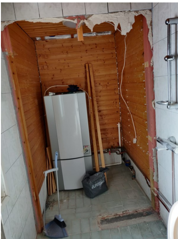
KUVA 7. Kohteen märkätila ja purettu väliseinä
