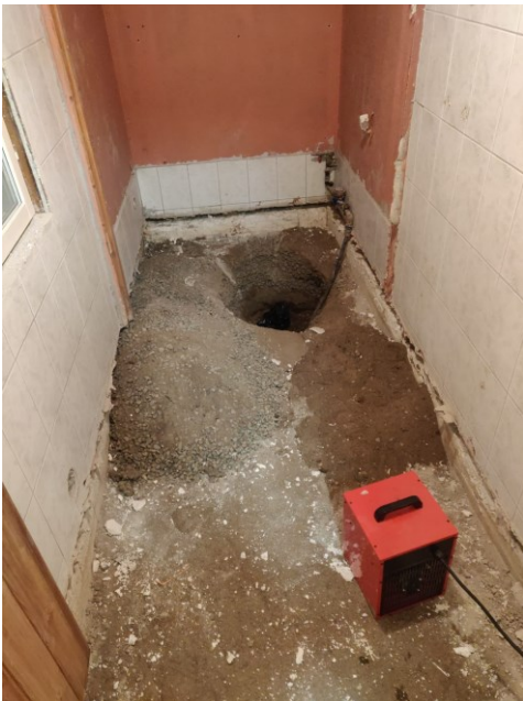
KUVA 15. Pois piikattu lattiakaivo ja kostunut maa-aines poistettu
