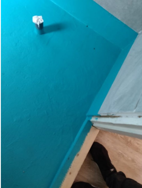
KUVA 27. Vedeneriste nostettu seinän vedeneristeen ja listan päälle
