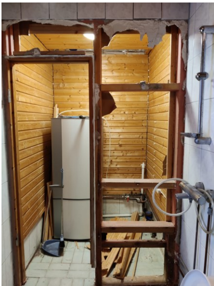
KUVA 12. Kostunut väliseinä päätettiin purkaa
