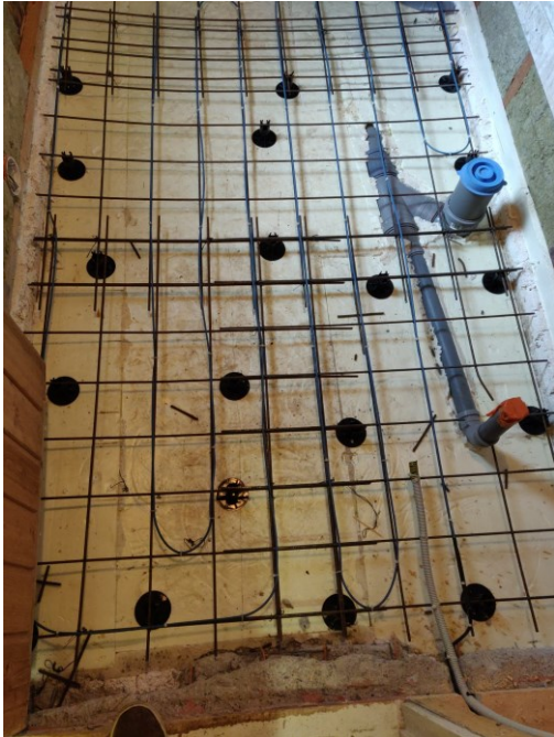
KUVA 20. Lattialämmityskaapelien asennus riviasennuksena
