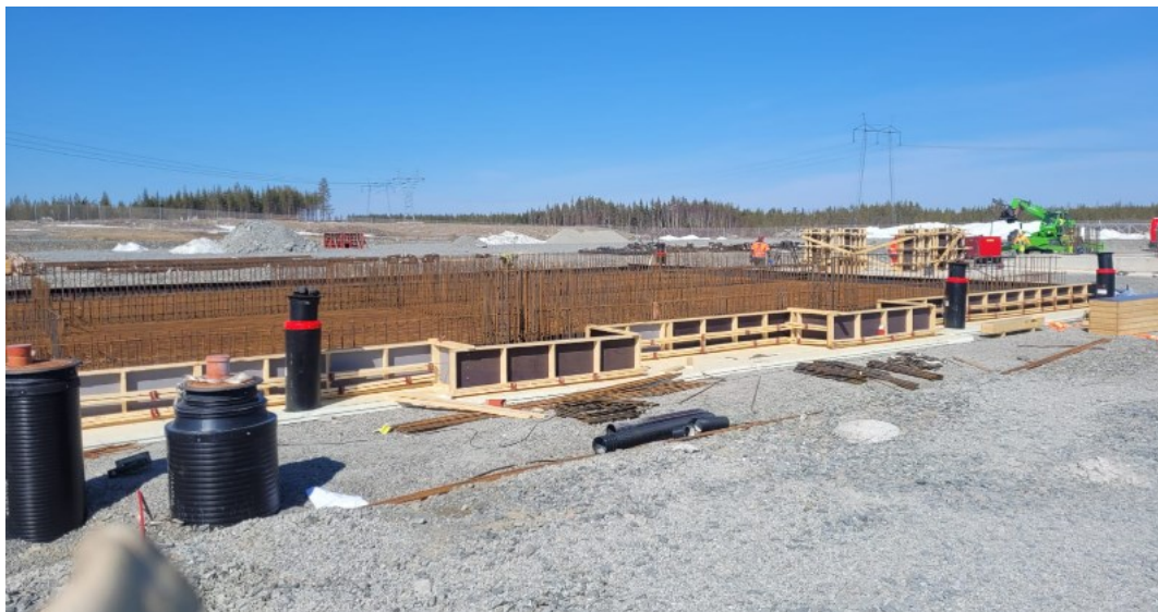
Kuva 8. Muuntajabunkkerin pohjalaatan raudoitus (Nätti 2023)
