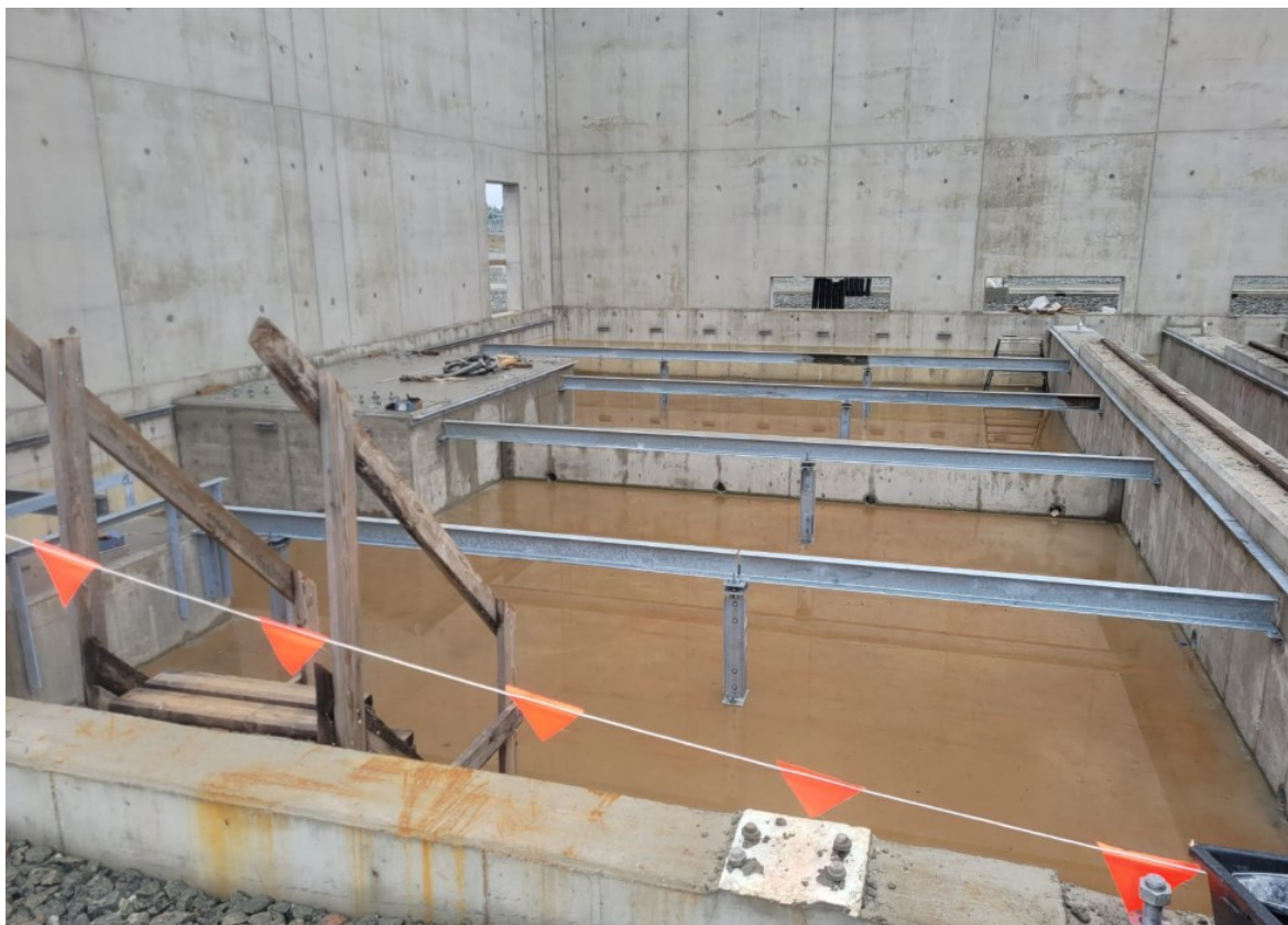
Kuva 6. Muuntajabunkkerin suojaseinien sisälle asennettavien liekkiloukkujen metallirungon asennustyöt aloitettu. (Nätti 2023)
