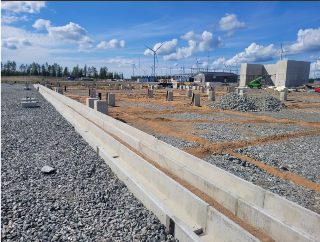
Kuva 4. Kaapelikanaalit, kojeperustukset ja maadoitusverkko asennettuna ennen lopullisia täyttöjä (Nätti 2023)
