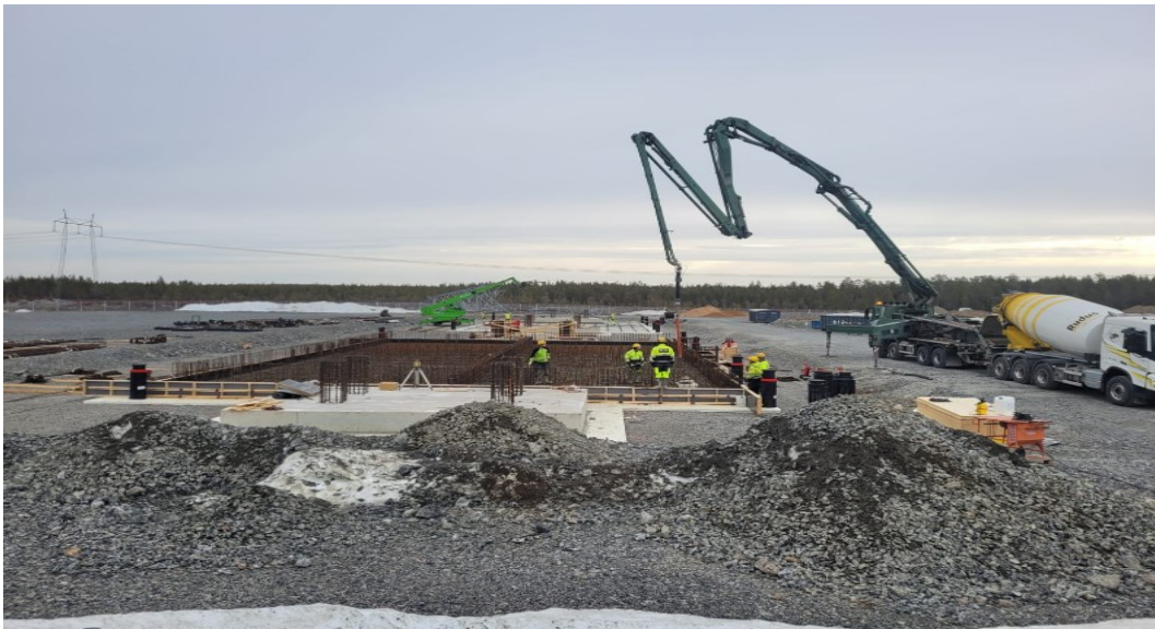
Kuva 9. Muuntajabunkkerin pohjalaatan betonointi (Nätti 2023)
